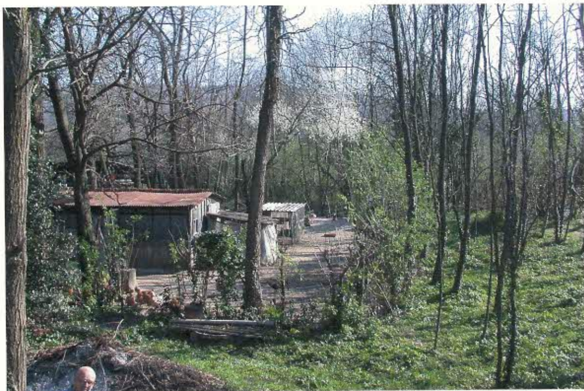
RIPRESA N° 3 – COSTRUZIONI ACCESSORIE SU P.C. 634/133
