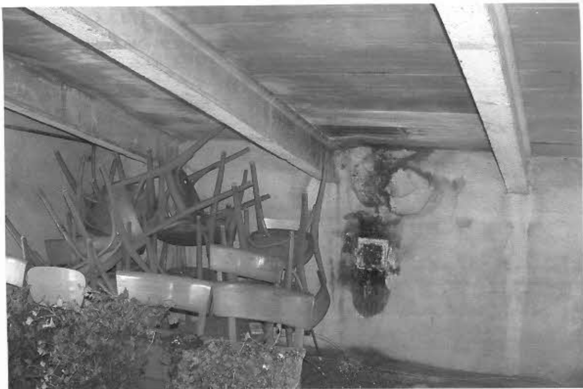
RIPRESA N° 7 – PARTICOLARE DELLA COPERTURA
