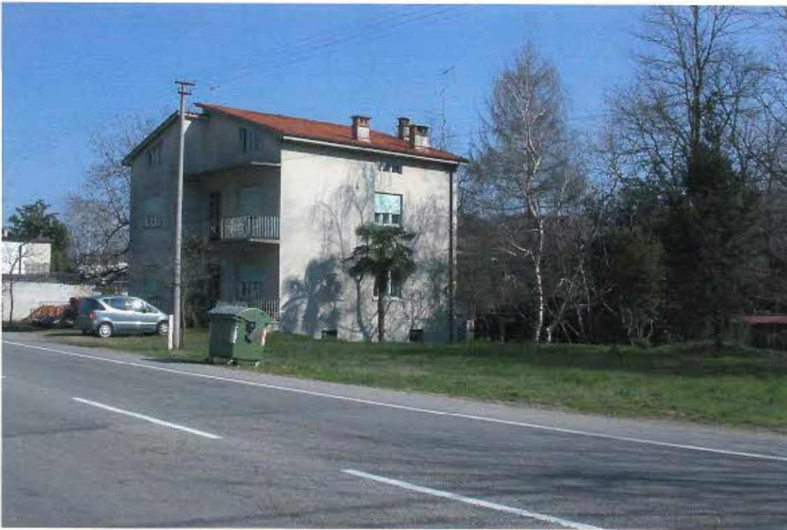
RIPRESA N° 1 – CASA UNIFAMILIARE VISTA DA VIA GORIZIA (STRADA STATALE GORIZIA-GRADISCA D'ISONZO)
