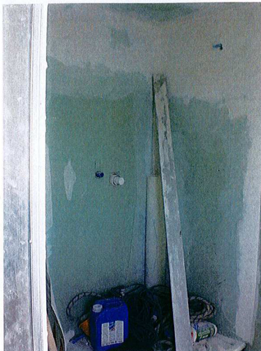
Particolare bagno stanza.
