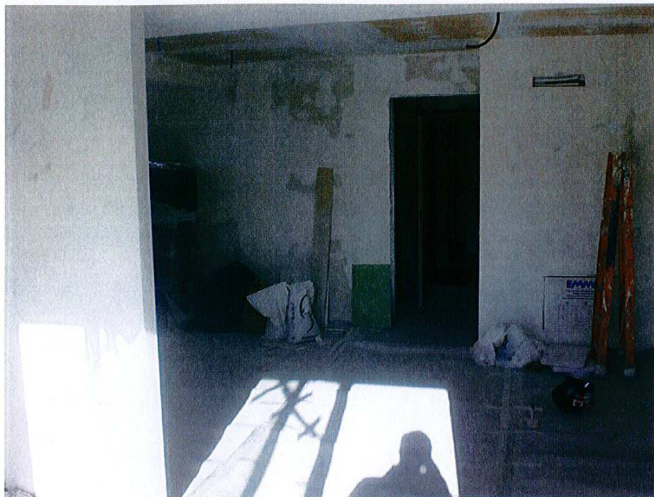
Soggiorno e ingresso appartamento.
