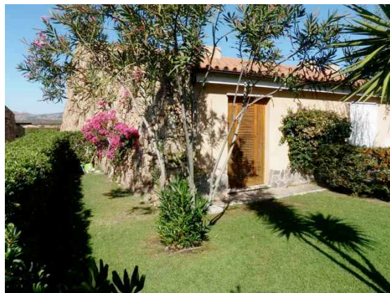
F. 6 La proprietà ripresa dal giardino di pertinenza
