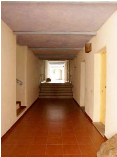
F. 9 Androne interrato che conduce alla proprietà Micocci
