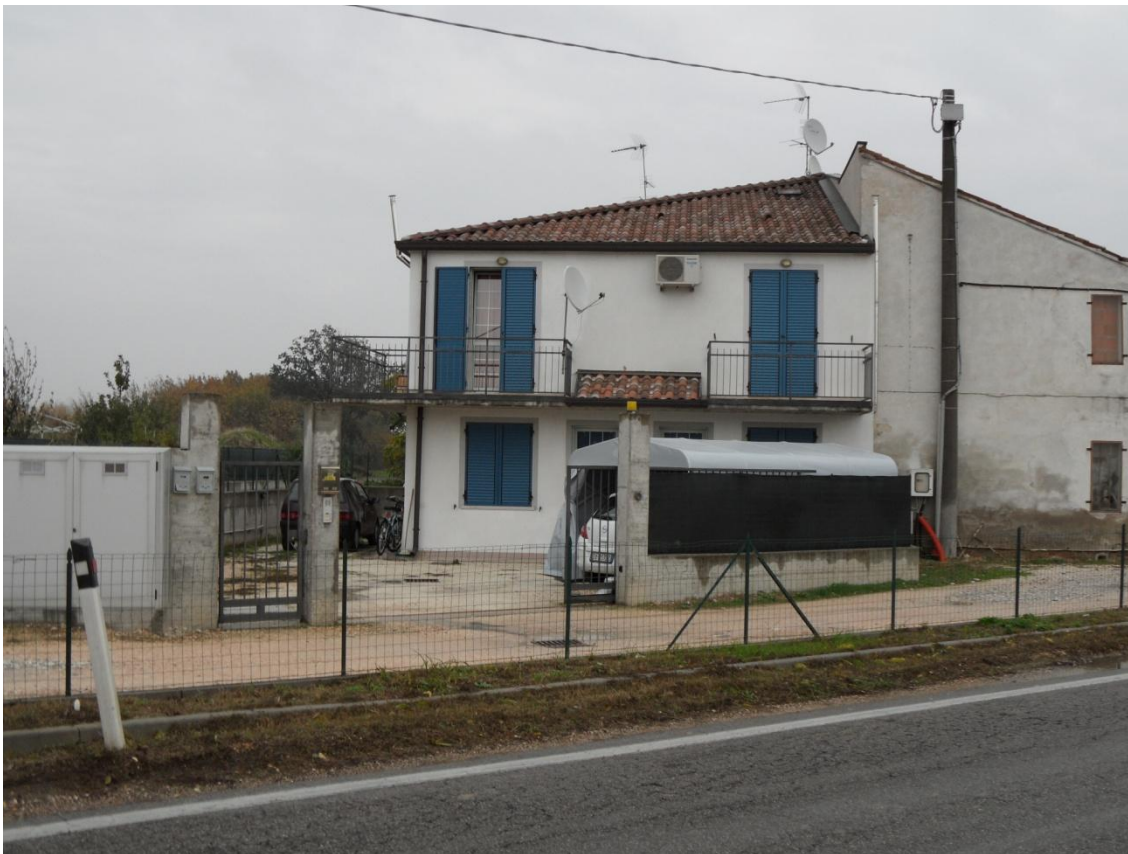
Foto n.1: accesso da via Bertolde, area cortiva e facciata
