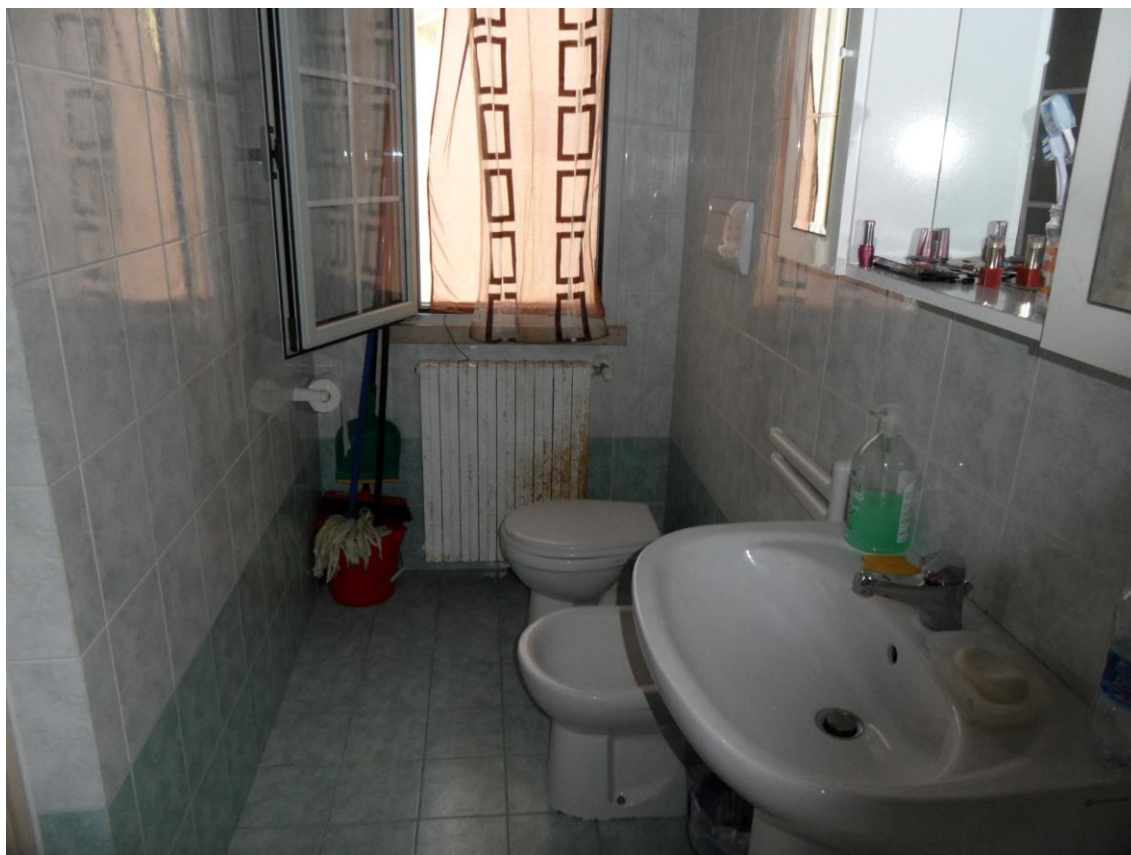
Foto n.6: bagno primo piano
