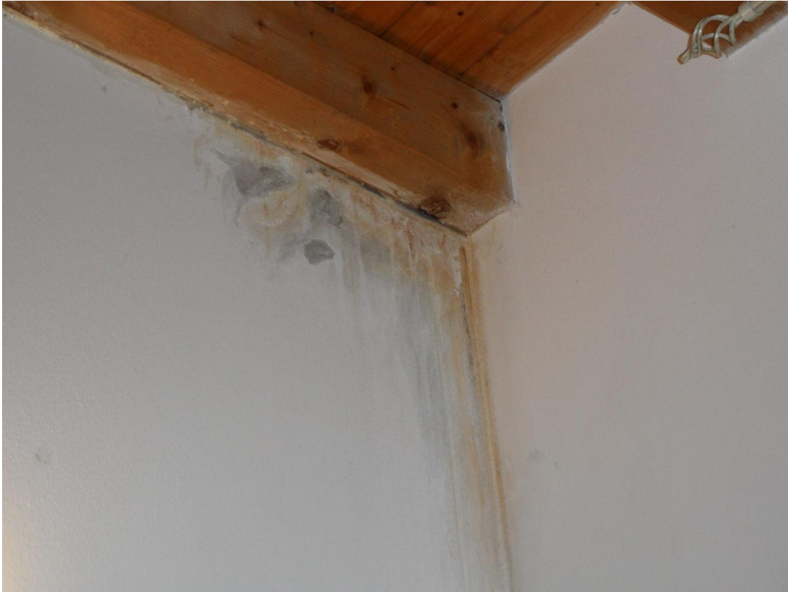
Foto n.7: infiltrazioni di acqua dal tetto
