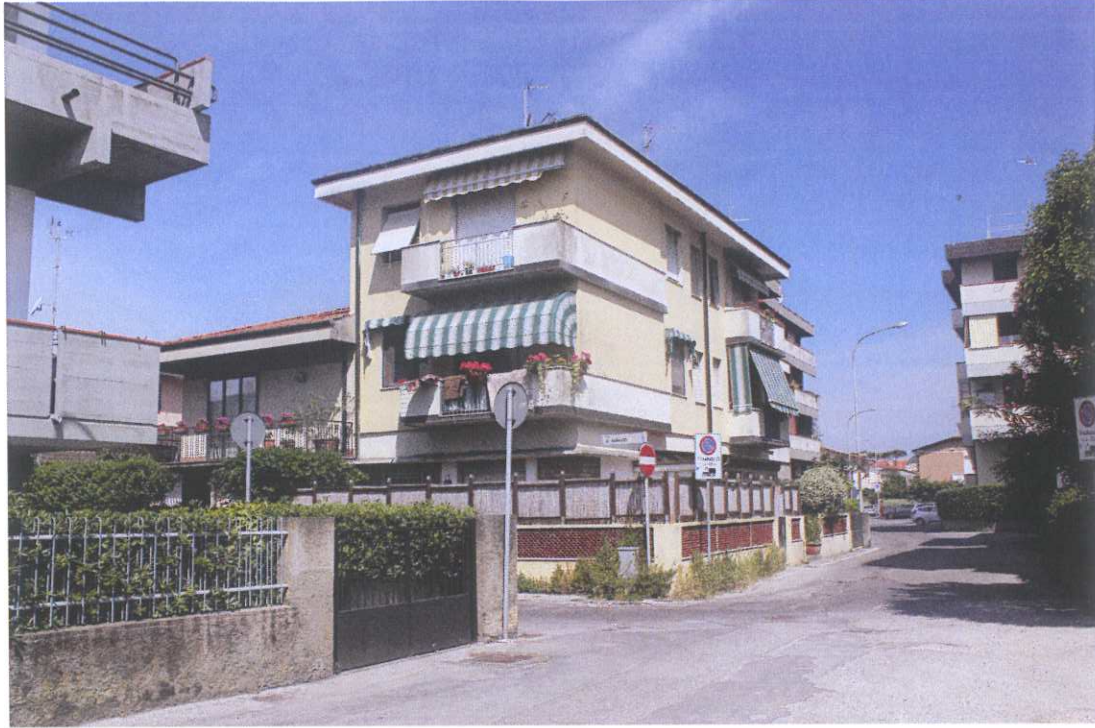
Foto 1 _ Prospetto Lato Sud
