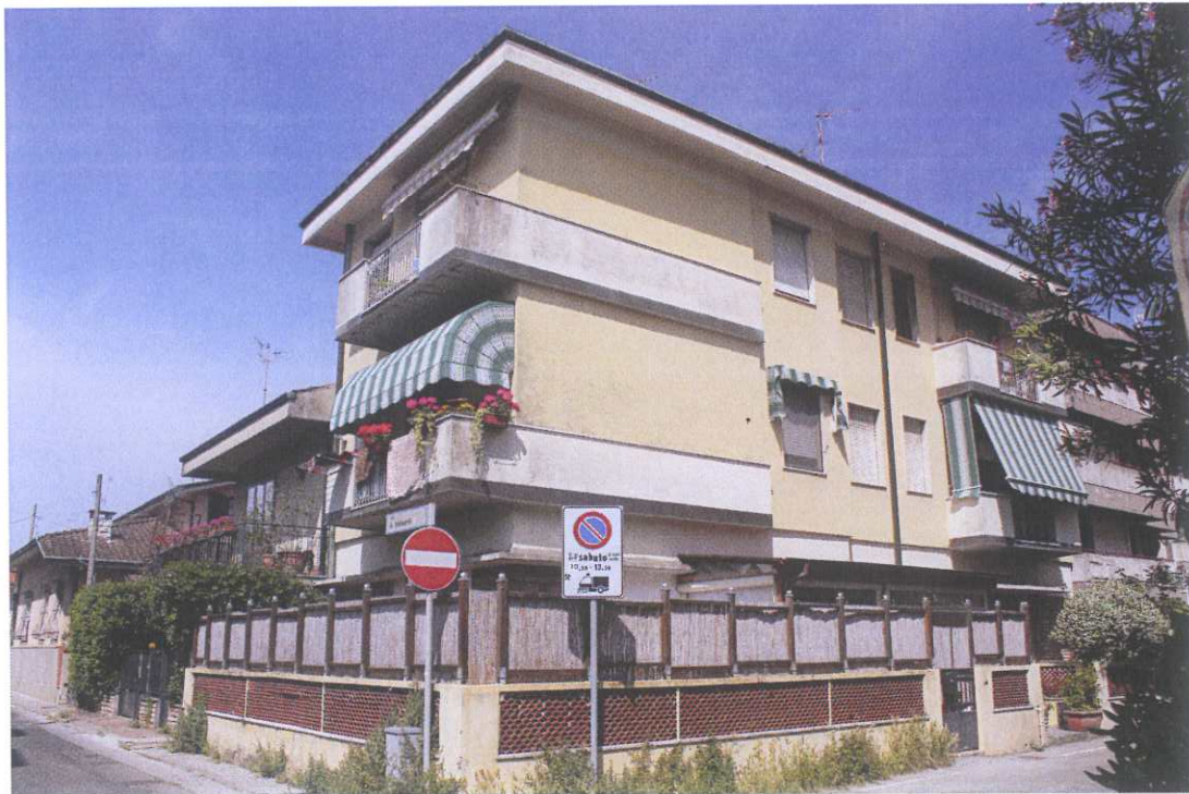
Foto 2 _ Prospetto Lato Est
