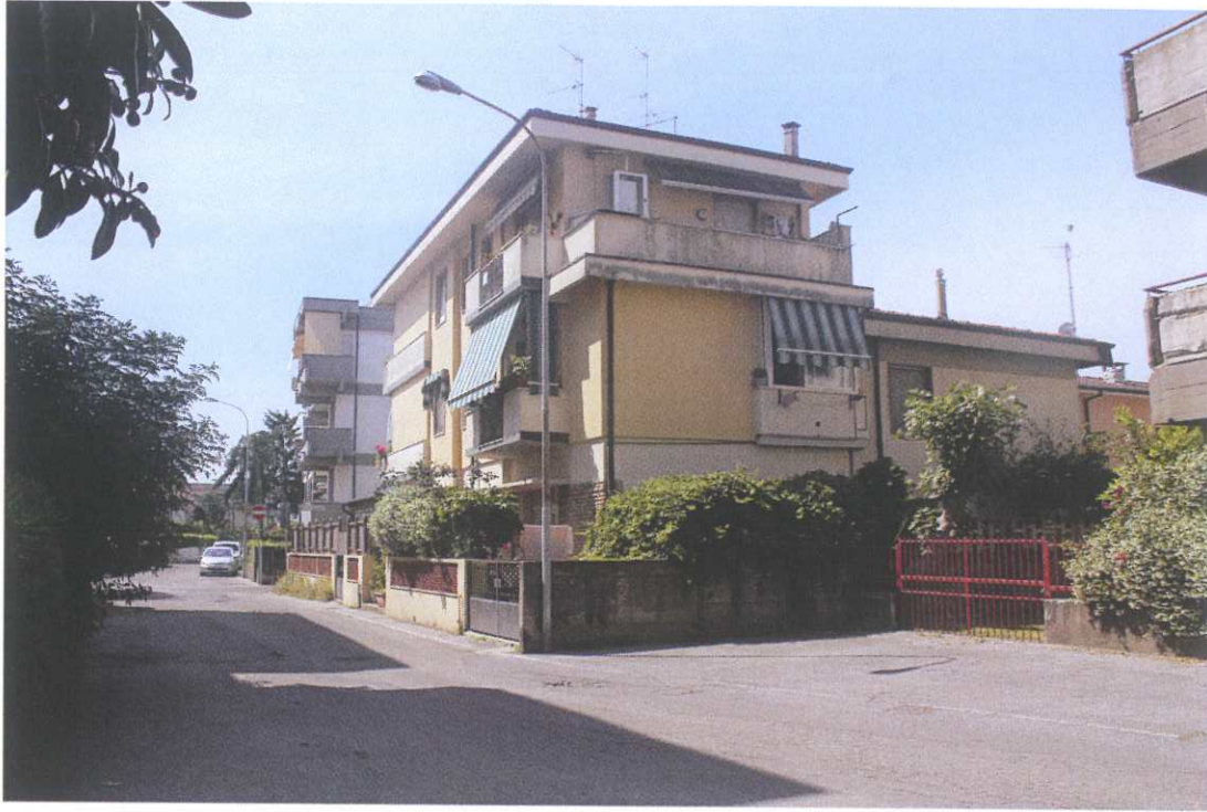
Foto 3 _ Prospetto Lato Nord
