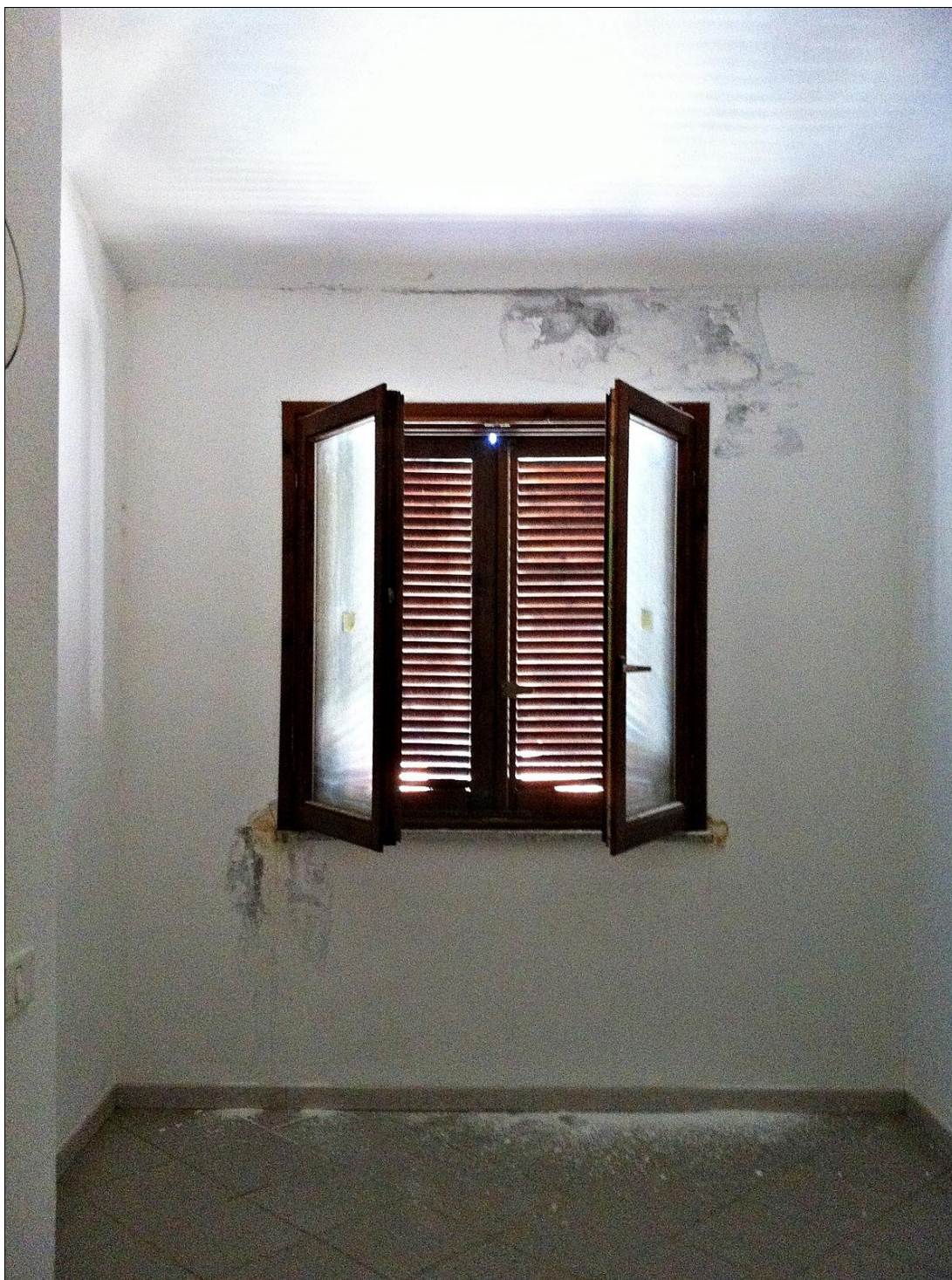
22 – Piano secondo. Vista sulla camera minore (muro perimetrale con infiltrazioni di umidità)
