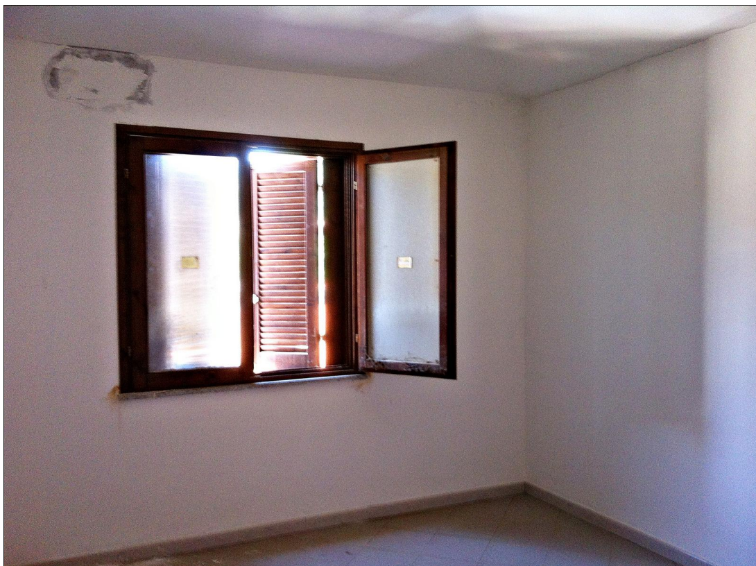
16 – Piano secondo. Vista sulla camera maggiore (muro perimetrale con le infiltrazioni di umidità dalla copertura)
