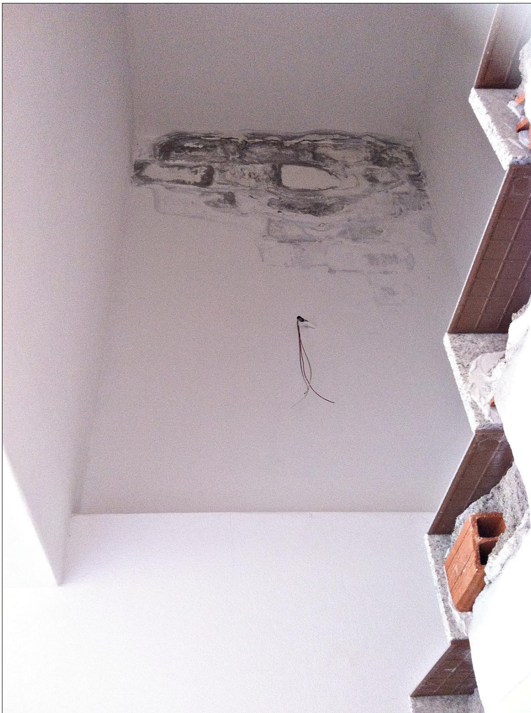
15 – Piano primo. Scala interna e muro perimetrale con le infiltrazioni di umidità dalla copertura
