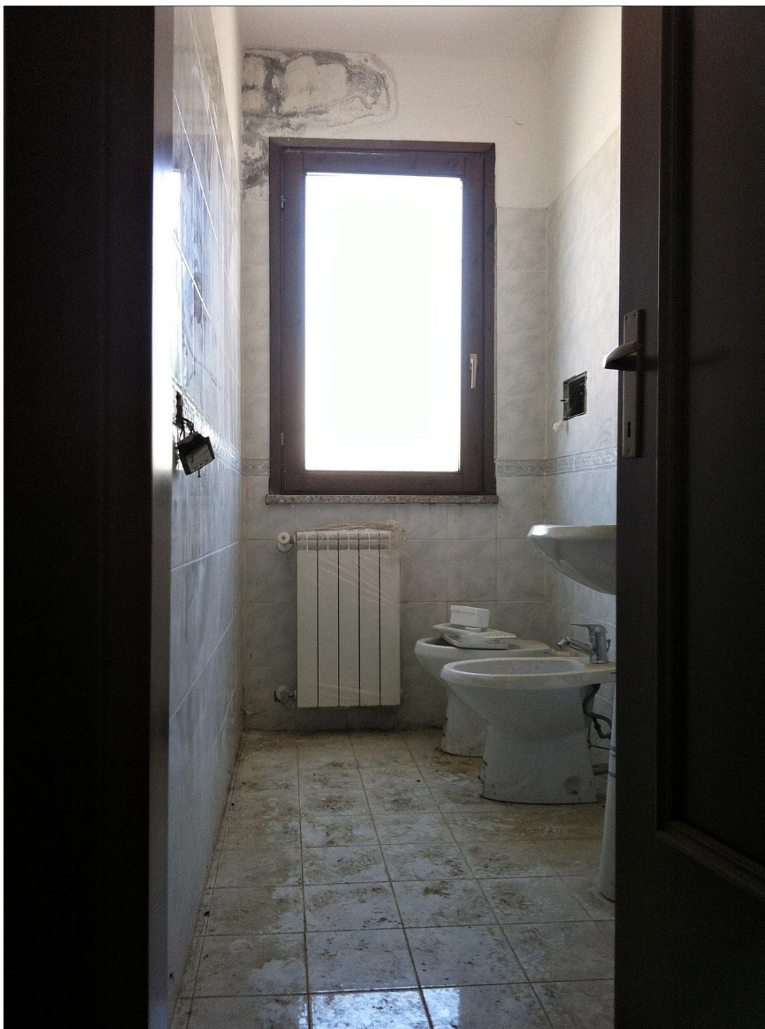
18 – Piano secondo. Vista sul bagno (muro perimetrale con le infiltrazioni di umidità dalla copertura, impianti incompleti e manomessi)
