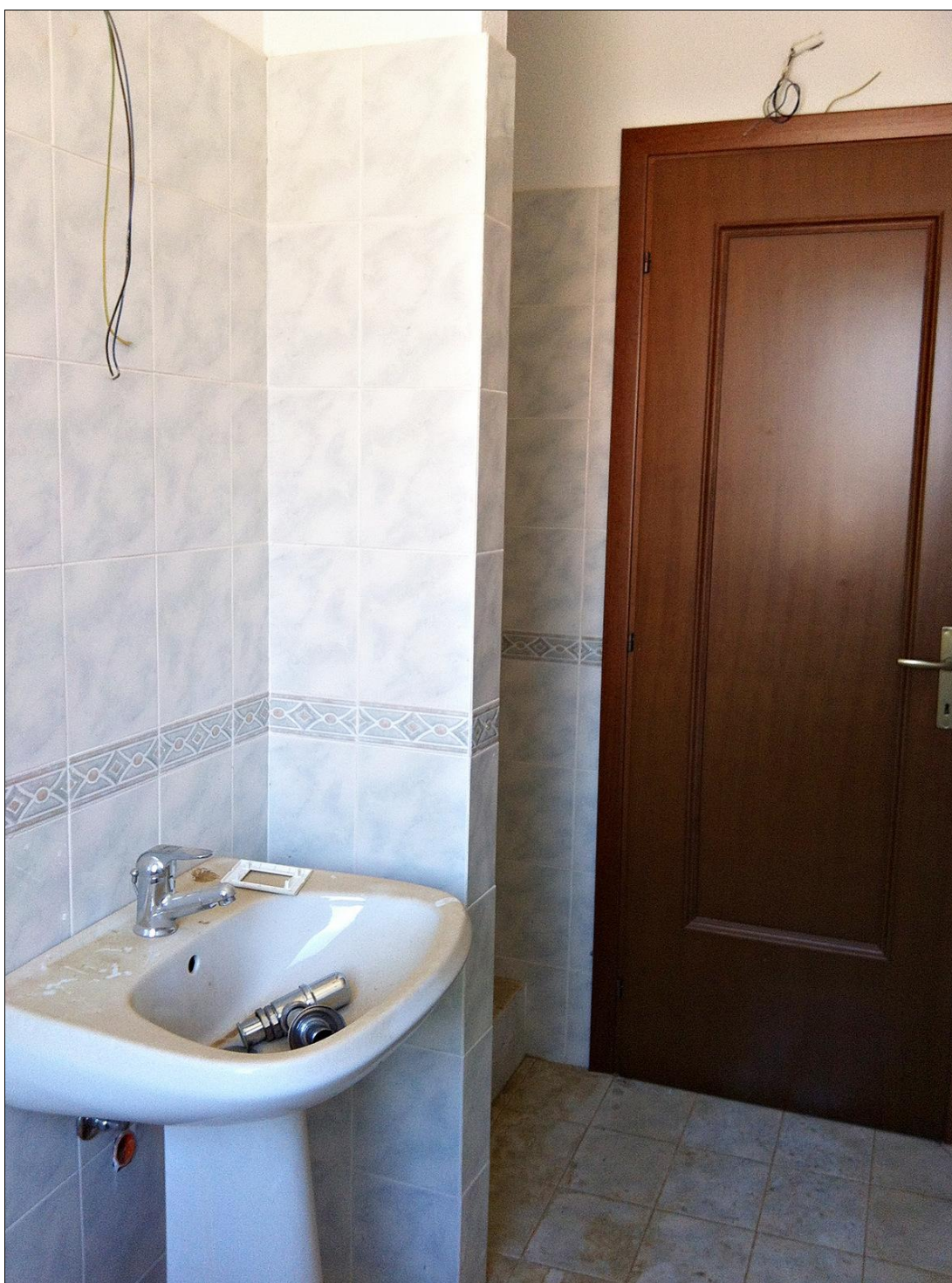
19 – Piano secondo. Vista sul bagno (impianti incompleti e manomessi)
