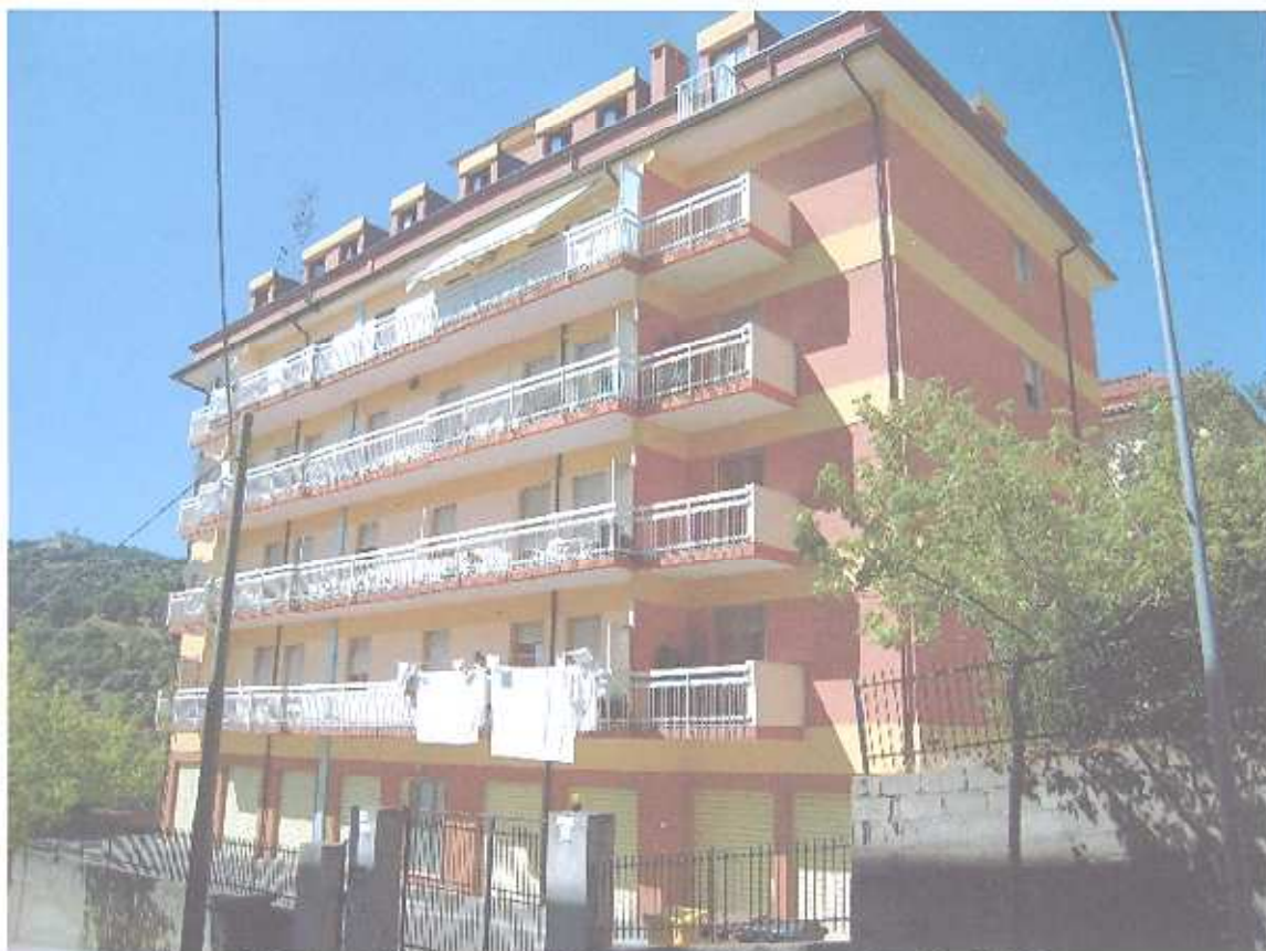
FOTO 1 - NUORO - ESTERNO EDIFICIO SU VIA VELIO SPANO
