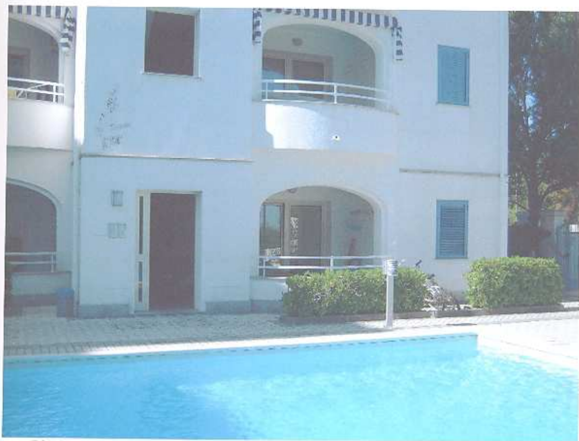
FOTO 7 - LA CALETTA - INGRESSO CONDOMINIALE E VERANDA VERSO PISCINA
