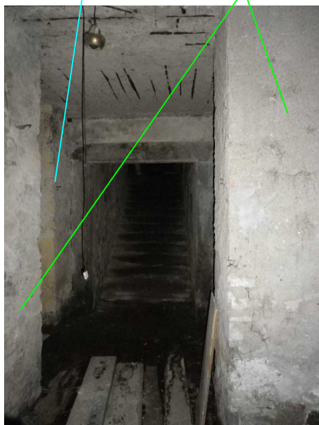
5) sbarco scale al piano interrato (accesso alla chiostra) (accesso agli altri locali)
