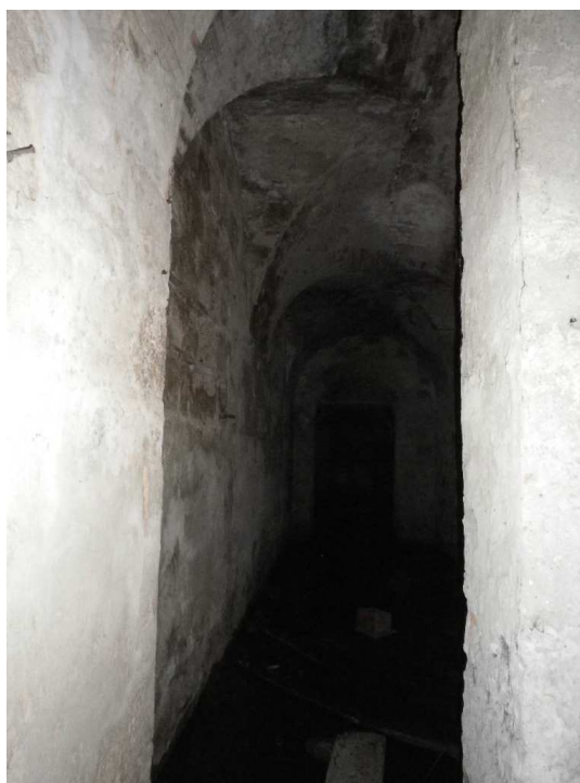
8) vista dei locali in direzione del fosso reale
