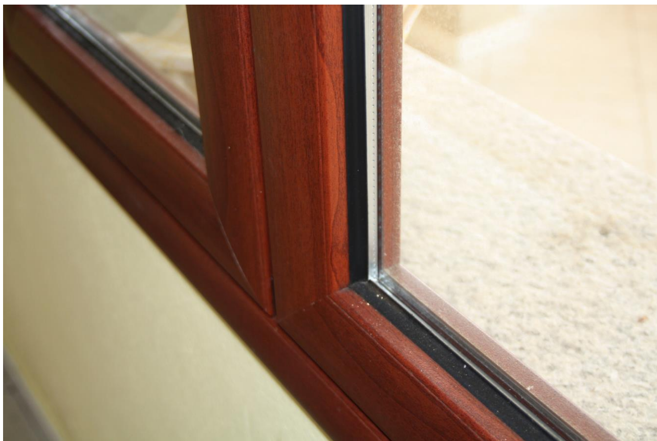
Foto n. 24 – Particolari costruttivi: dettaglio infisso con vetro 4-6-4 mm.
