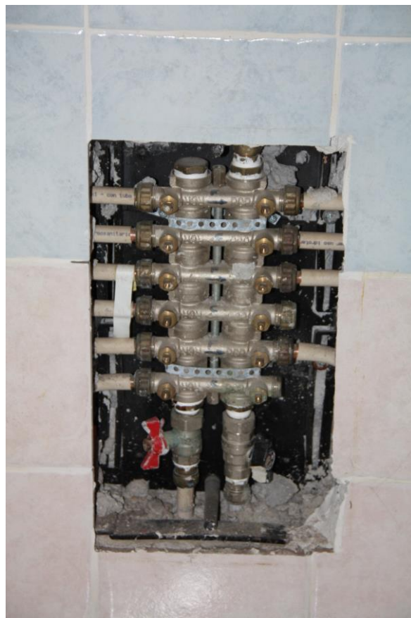
Foto n. 31 – Particolari costruttivi: tubazione impianto idrico sanitario.
