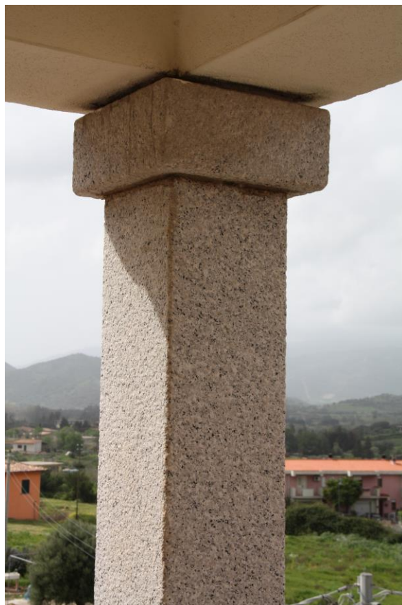
Foto n. 21 – Particolari costruttivi: pilastri verande in granito.
