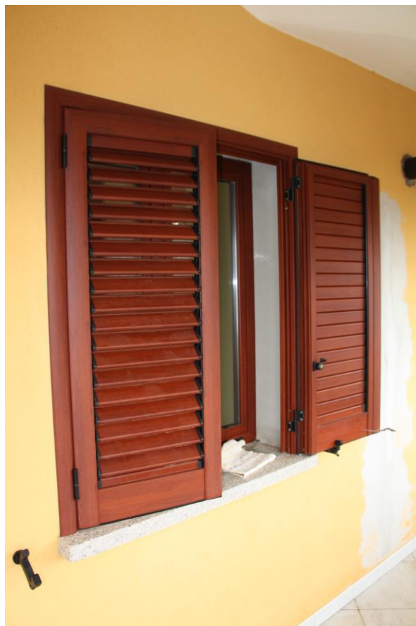
Foto n. 23 – Particolari costruttivi: infissi in p.v.c. con persiane.
