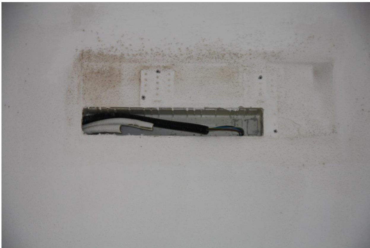
Foto n. 34 – Particolari costruttivi: predisposizione impianto di climatizzazione nel vano letto.
