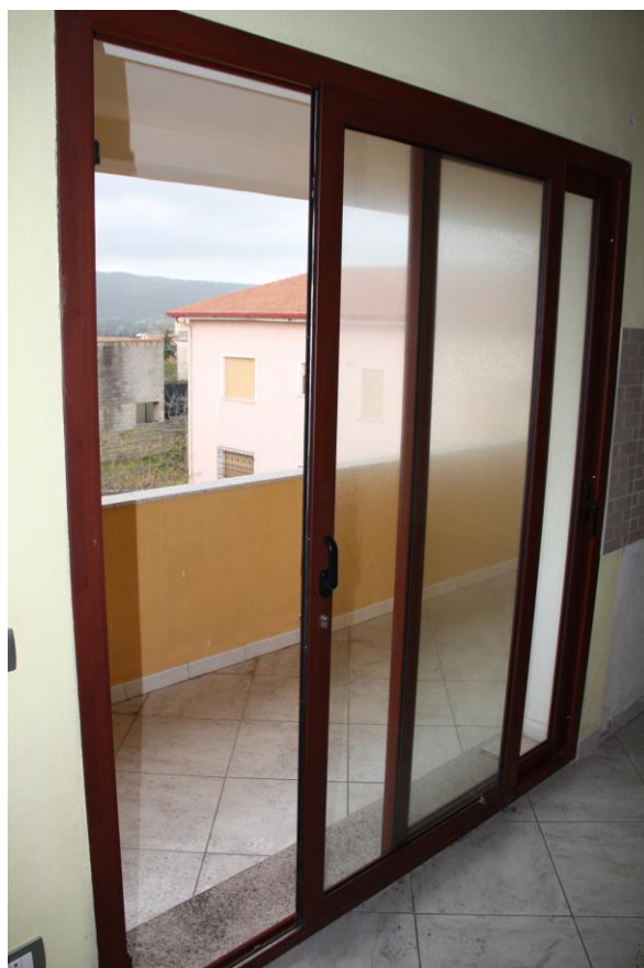
Foto n. 22 – Particolari costruttivi: infissi in p.v.c.
