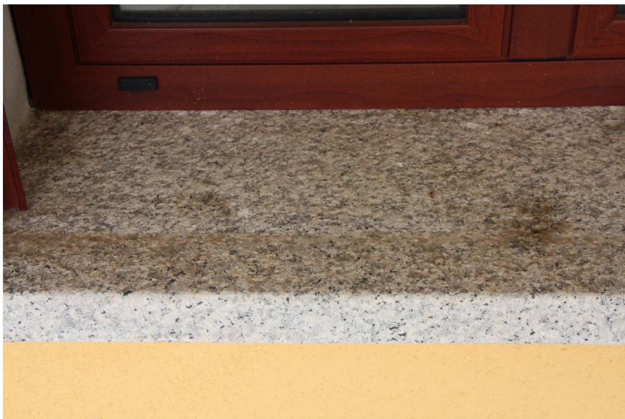
Foto n. 25 – Particolari costruttivi: soglie davanzali degli infissi in granito.
