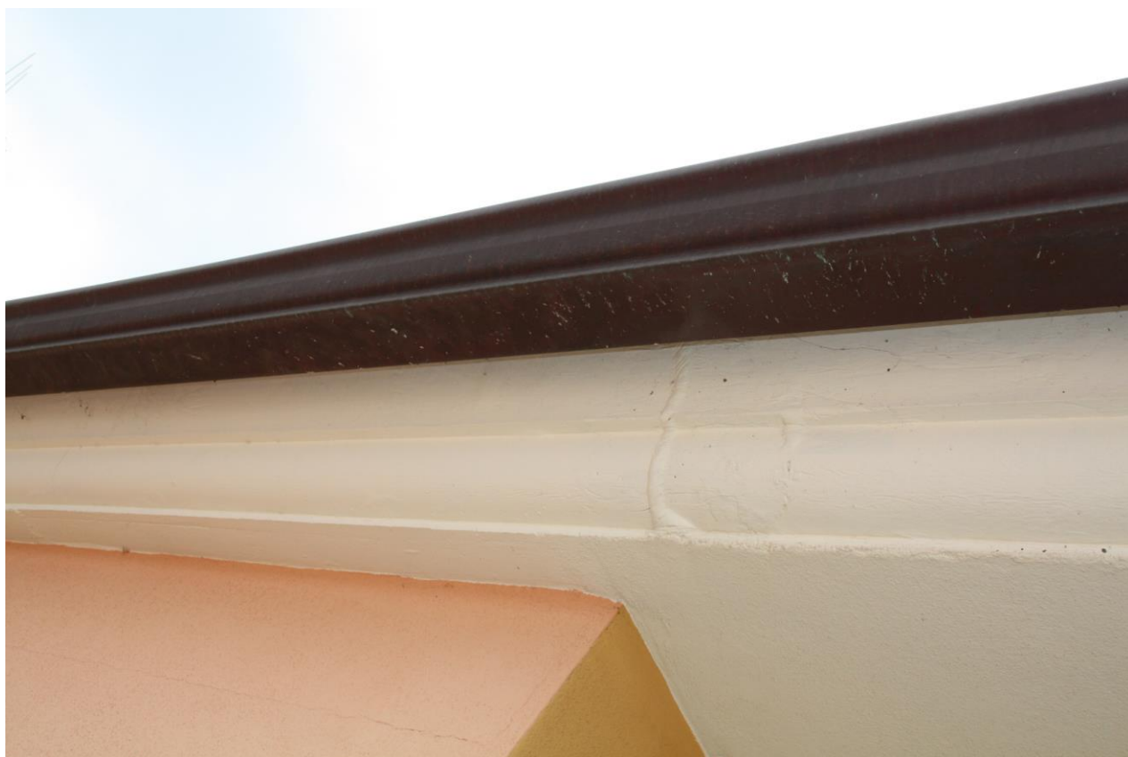
Foto n. 26 – Particolari costruttivi: gronde della copertura in rame.
