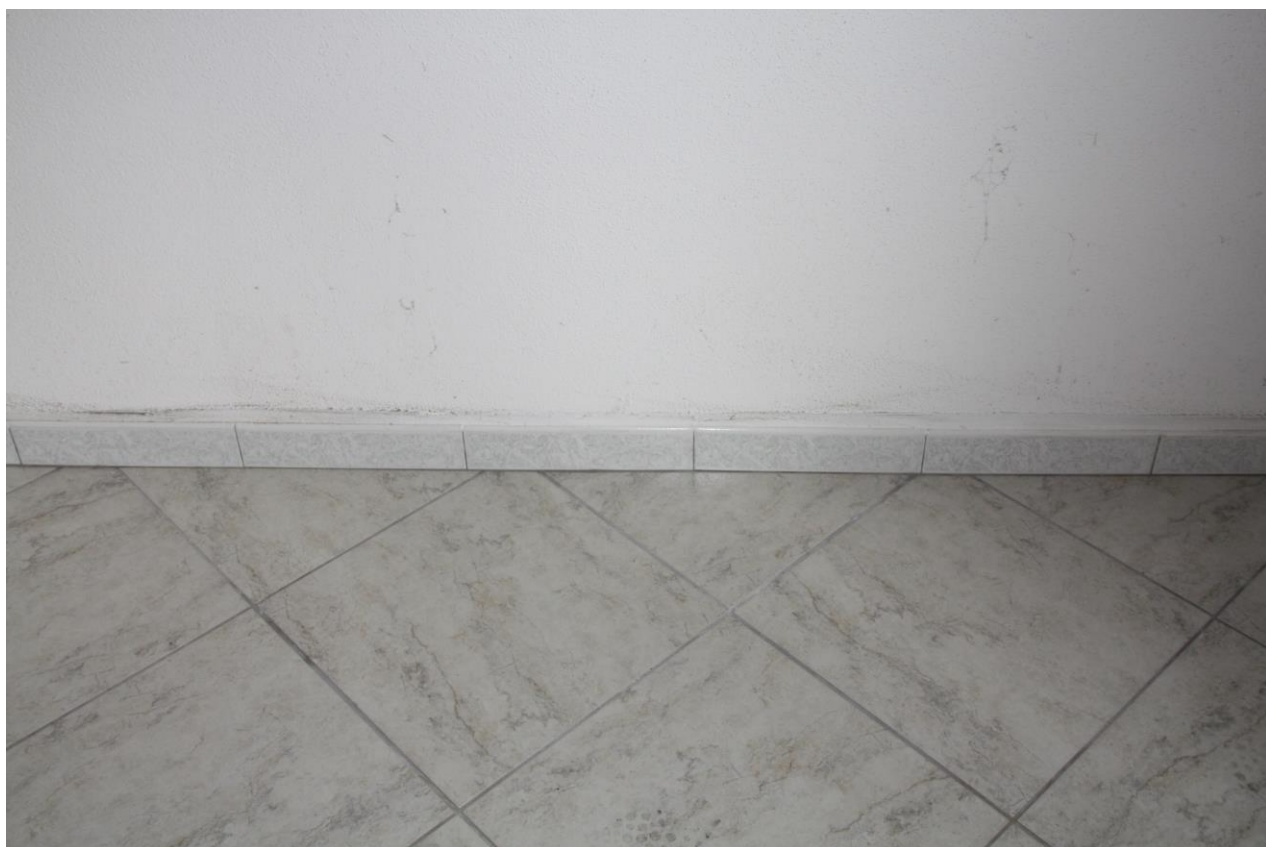
Foto n. 27 – Particolari costruttivi: pavimenti interni e battiscopa in gres porcellanato.
