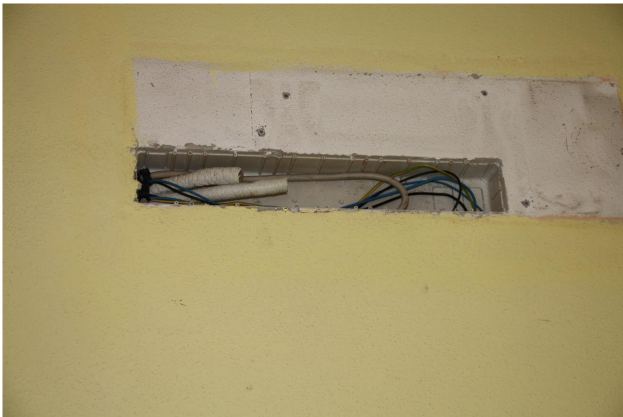
Foto n. 33 – Particolari costruttivi: predisposizione impianto di climatizzazione nel vano soggiorno pranzo.
