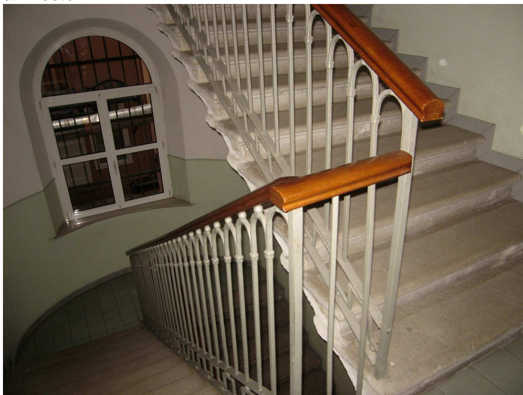
FOTO 12: vano scale condominiale dell'edificio di Via Ghega 15 a Trieste
