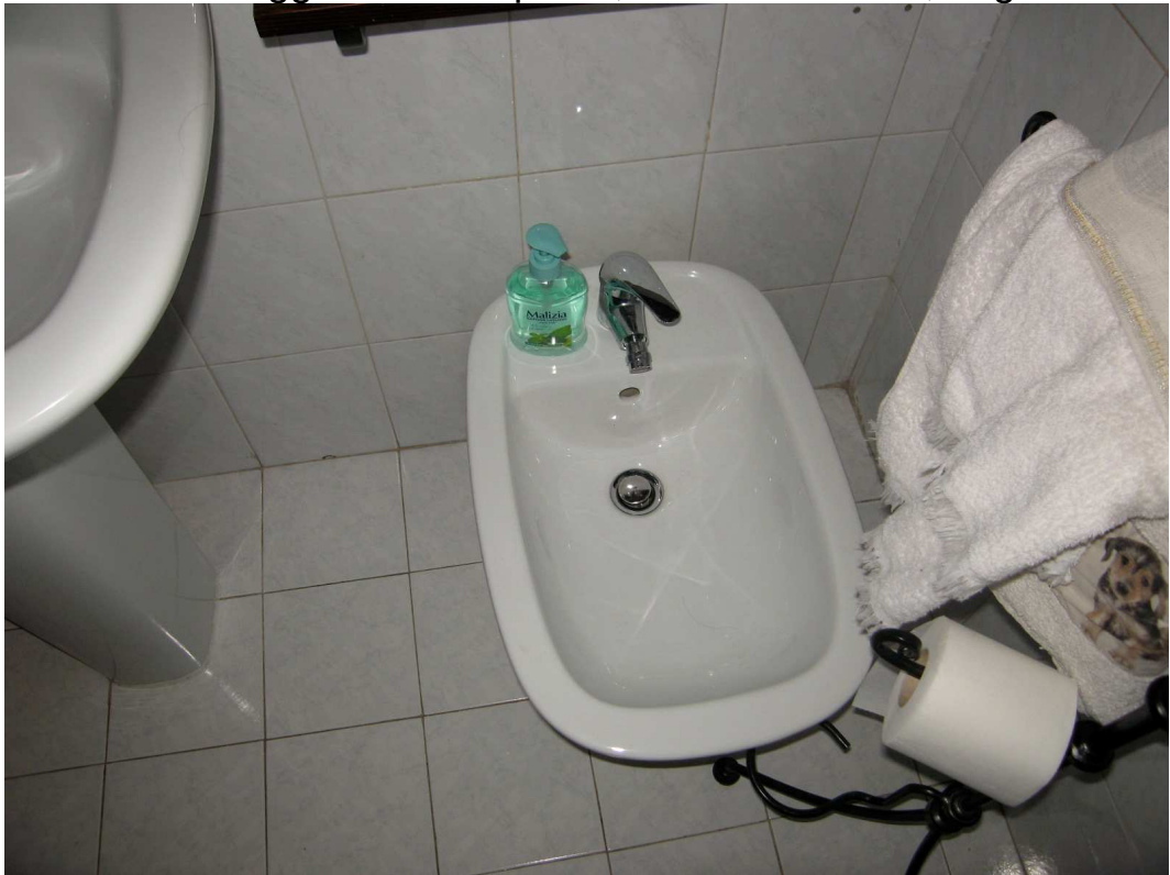
FOTO 41: Alloggio al terzo piano, subalterno "10", bagno w.c.
