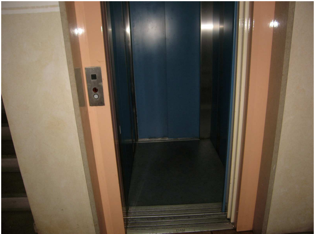
FOTO 10: atrio condominiale dell'edificio di Via Ghega 15 a Trieste - ascensore
