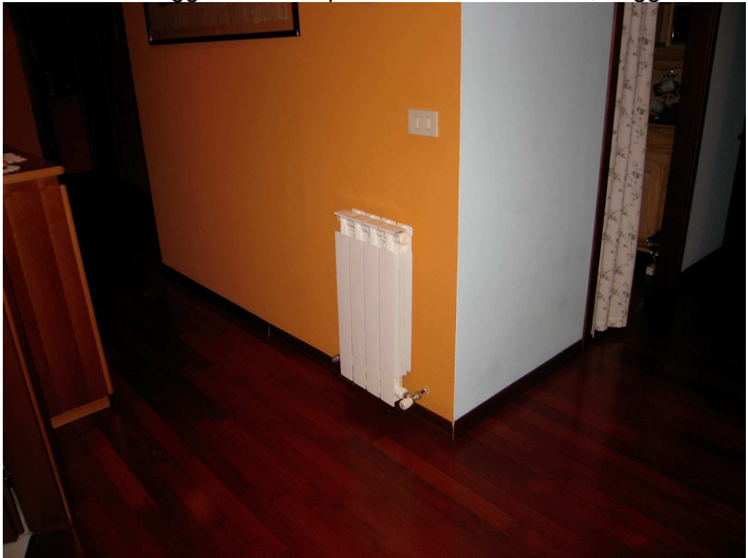
FOTO 21: Alloggio al terzo piano, subalterno "10", soggiorno
