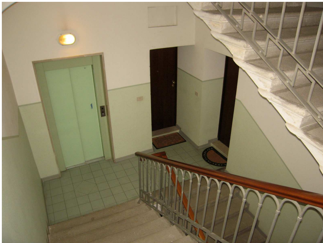
FOTO 13: vano scale condominiale dell'edificio di Via Ghega 15 a Trieste
