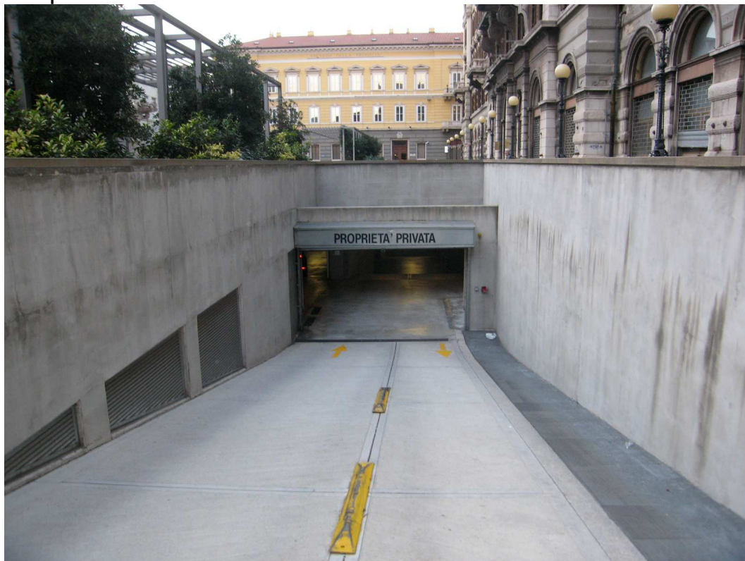
FOTO 51: autorimessa sotto piazza Vittorio Veneto, particolare rampa d'accesso carrabile
