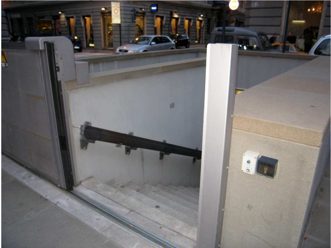
FOTO 53: autorimessa di piazza Vittorio Veneto, vano scale d'accesso/uscita pedonale
