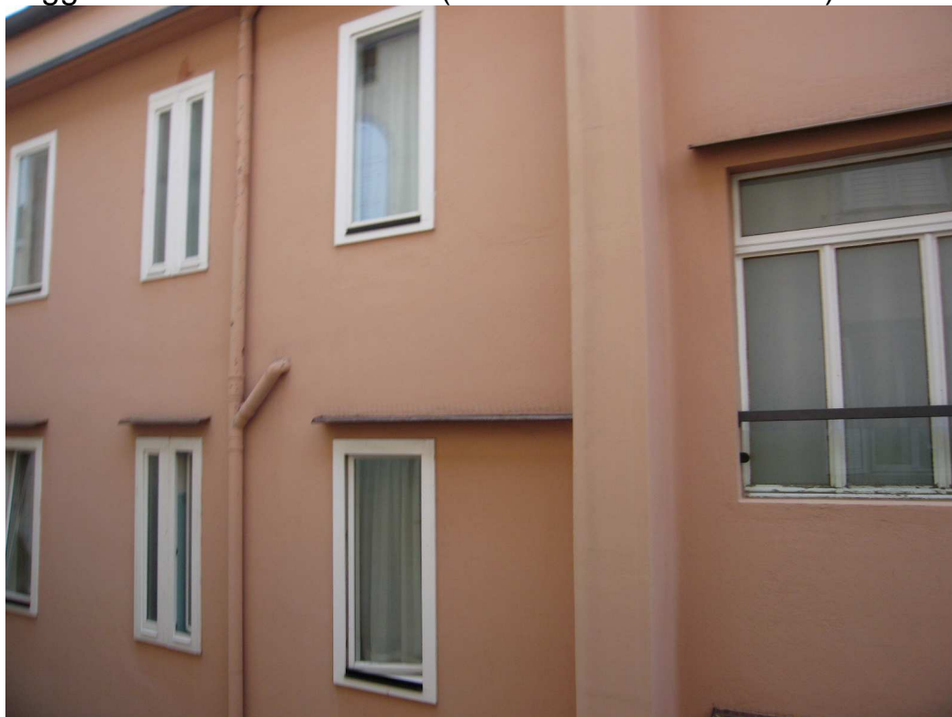
FOTO 48: Alloggio al terzo piano, subalterno "10", visuale dal soggiorno nella corte interna (vista dell'edificio di fronte)
