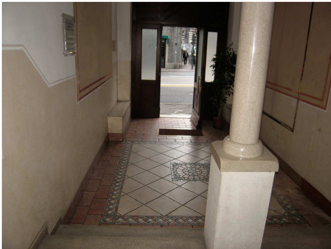
FOTO 7: edificio di Via Ghega 15 a Trieste a Trieste – atrio condominiale
