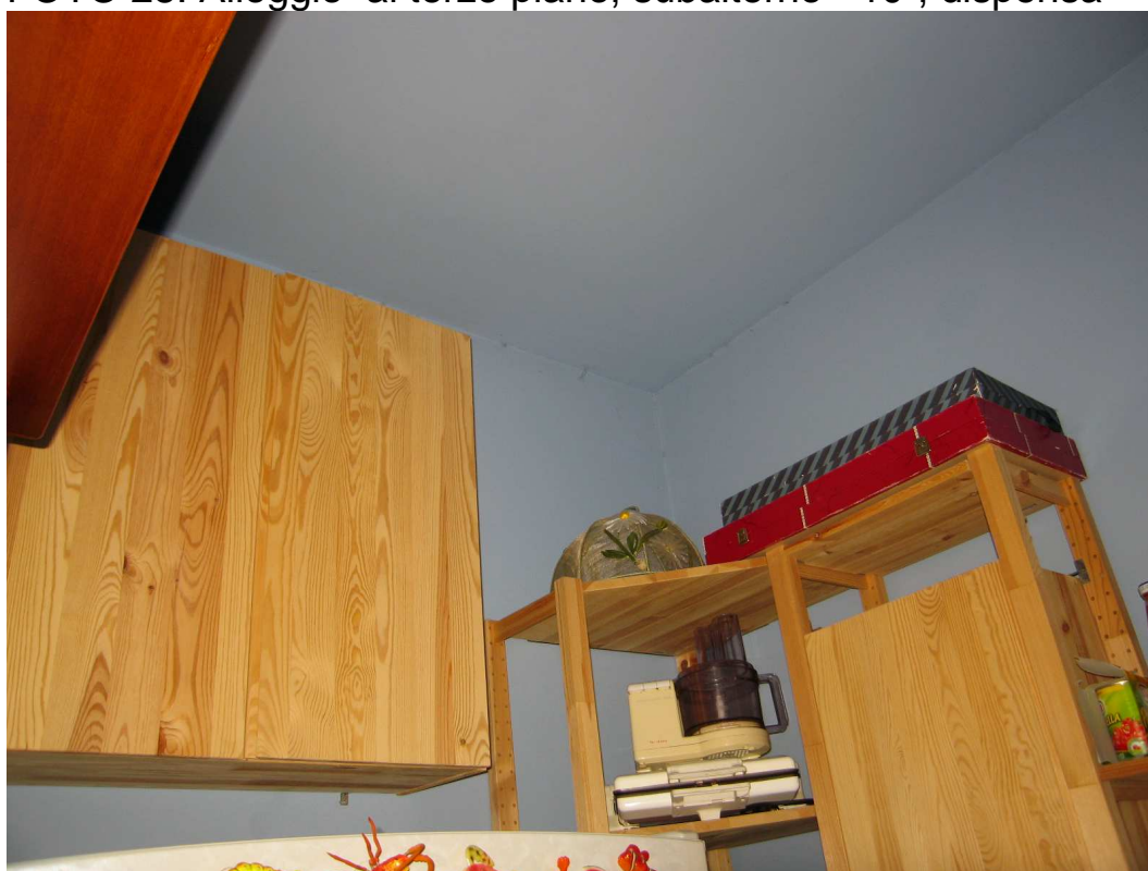
FOTO 28: Alloggio al terzo piano, subalterno "10", dispensa
