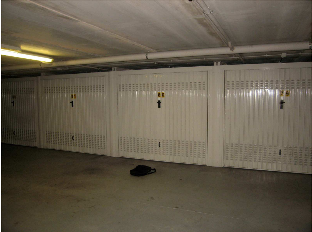
FOTO 55: autorimessa di piazza Vittorio Veneto, box auto ente "80" particolare basculanti
