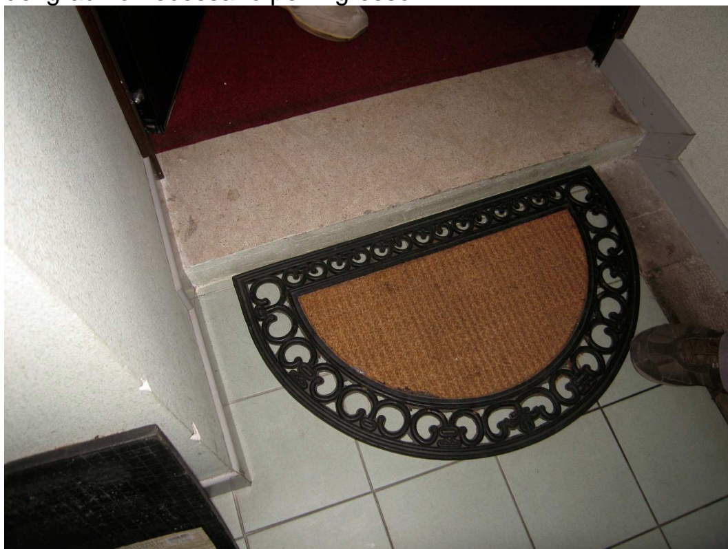
FOTO 14: Alloggio al terzo piano, subalterno "10", particolare del gradino necessario per ingresso
