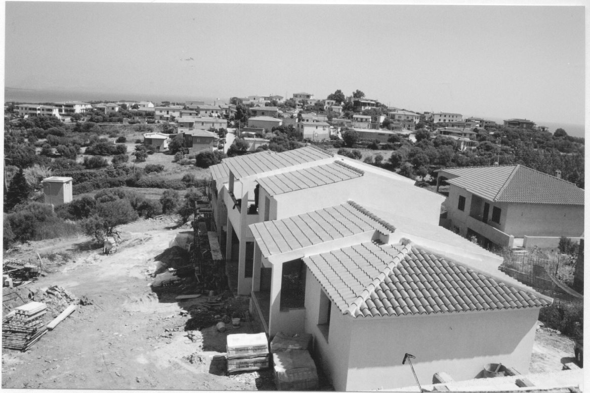
3) TANAUJELLA - COMPLESSO RESIDENZIALE IN COSTRUZIONE
