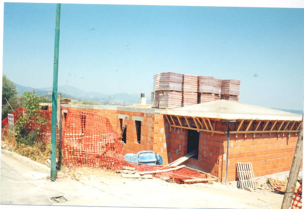
5) TANADUNELLA - COMPLESSO RESIDENZIALE IN COSTRUZIONE SU EX MAPP. 73-454 (CORPO 4)
