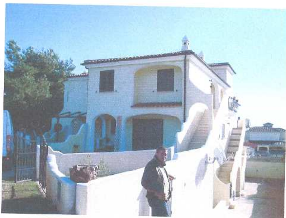
Foto n° 2: prospetti ovest e sud del fabbricato visti da Via Dei Mandorli
