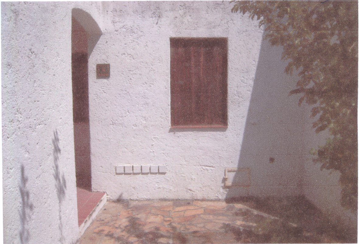
FOTO 24 - sub 84 - ESTERNO - CORTILE
