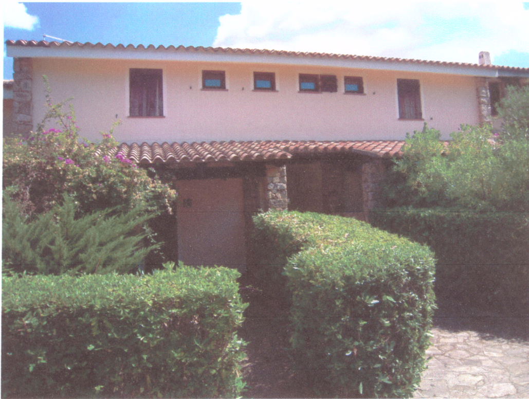
FOTO 07 - sub 2 e sub 3 - ESTERNO LATO OVEST
