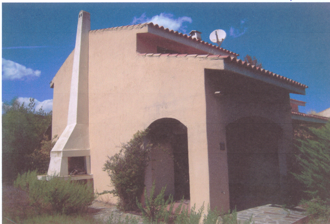
FOTO 02 - sub 1 - ESTERNO LATO SUD
