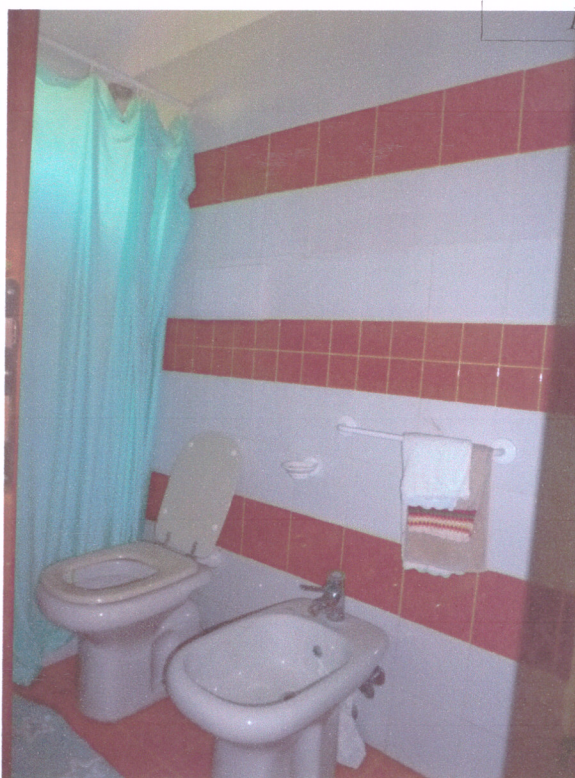
FOTO 16 - sub 2 - INTERNO PIANO PRIMO - BAGNO
