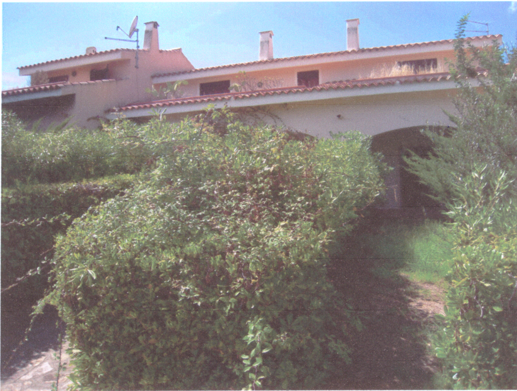
FOTO 09 - sub 2 e sub 3 - ESTERNO LATO EST
