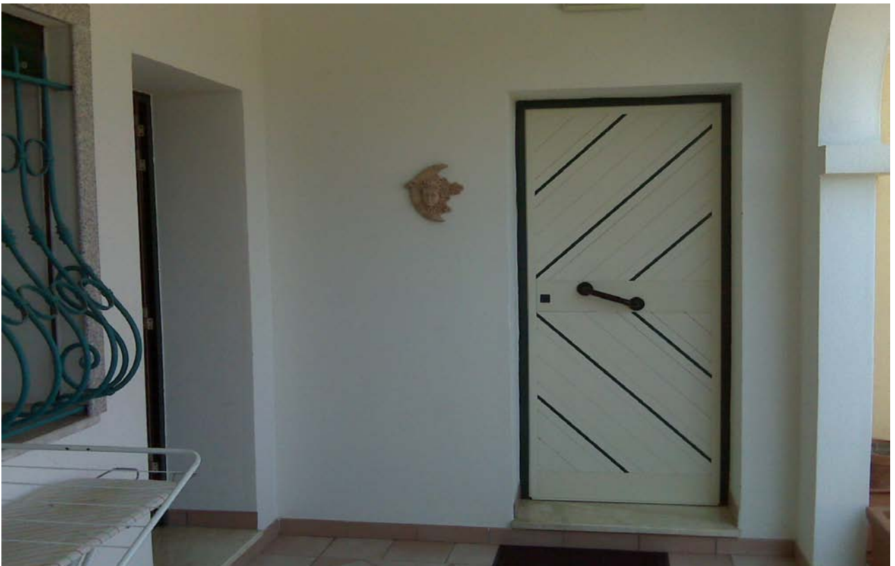
Unità immobiliare piano primo. Ingresso abitazione
