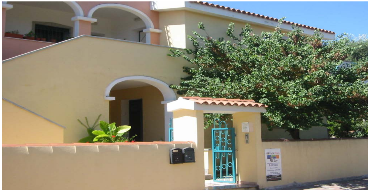
Vedute edificio dalla strada
