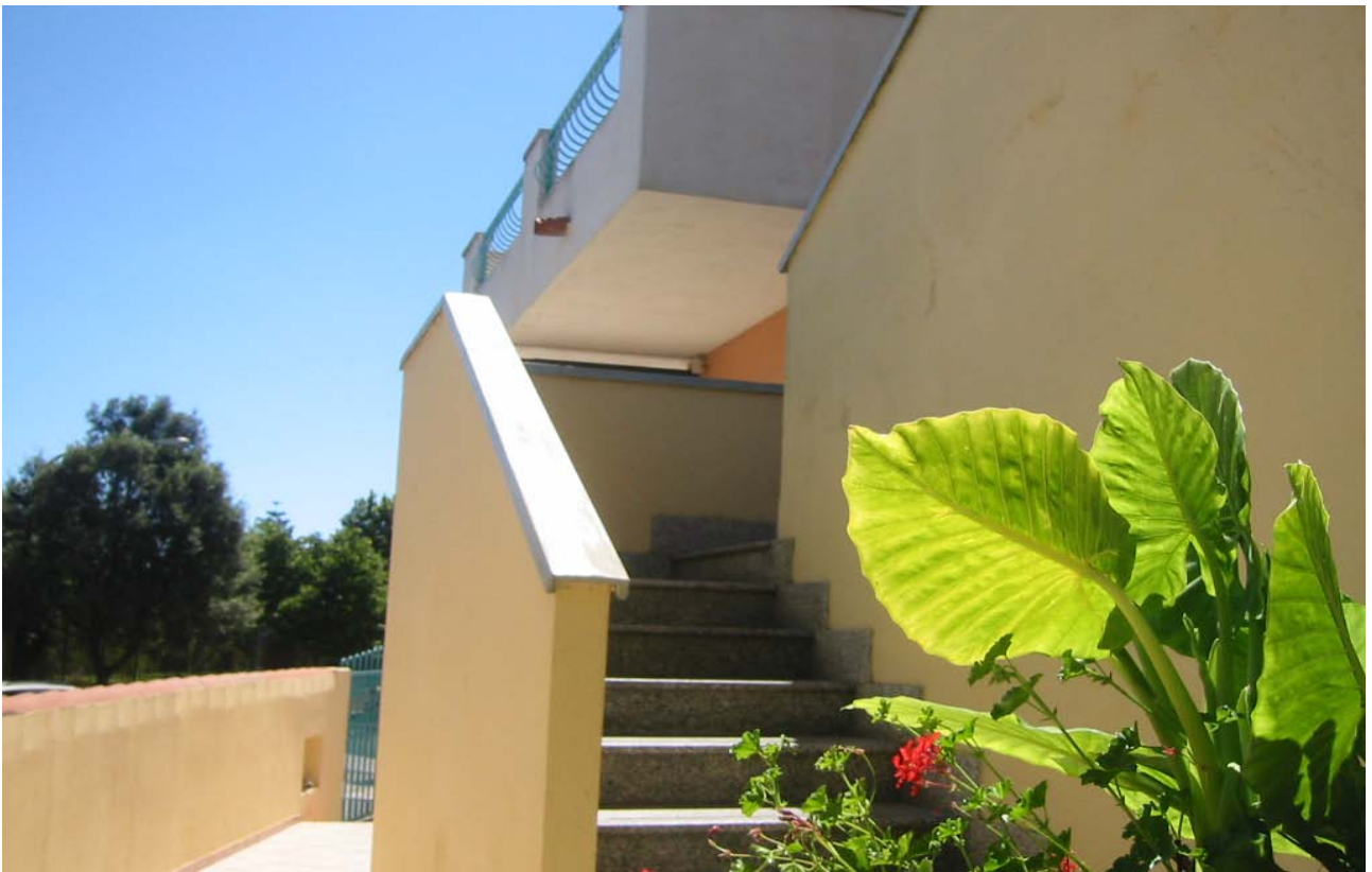
Vedute edificio dal cortile
