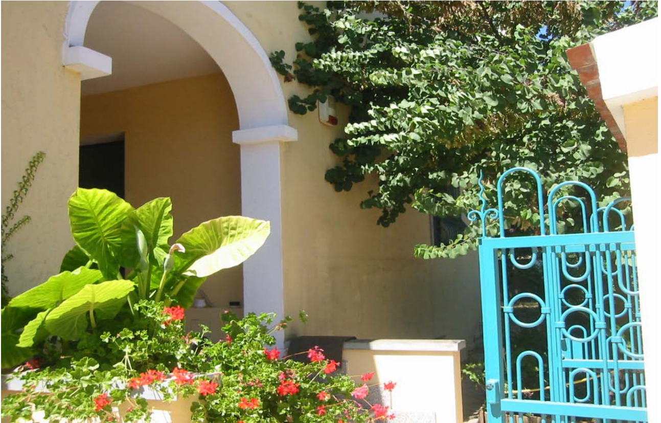
Ingresso principale piano terra.
