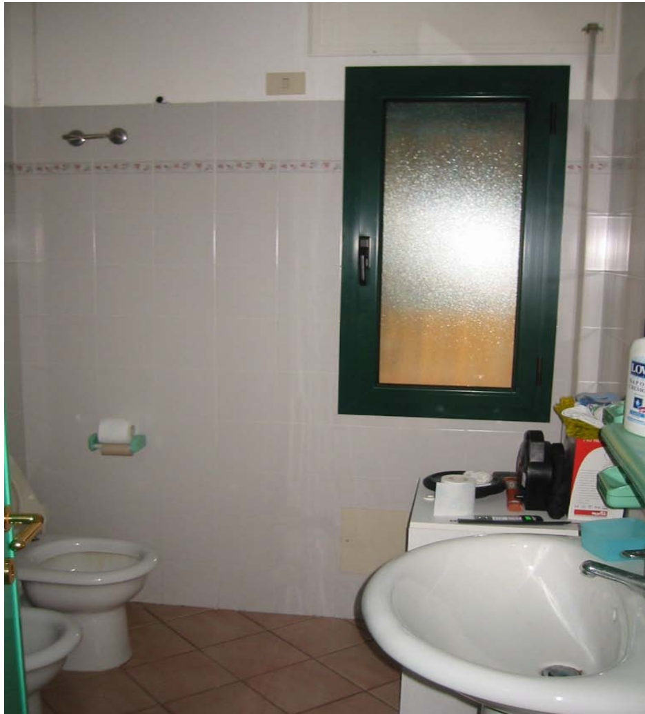
Unità immobiliare piano terra – artigianale.
