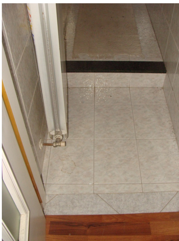
Foto n.20 – Dislivello pavimento del bagno - wc
