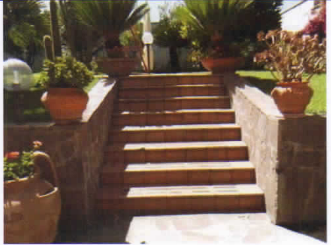
Foto 72 : Scala che dallo spazio esterno da accesso al giardino ed alla piscina
