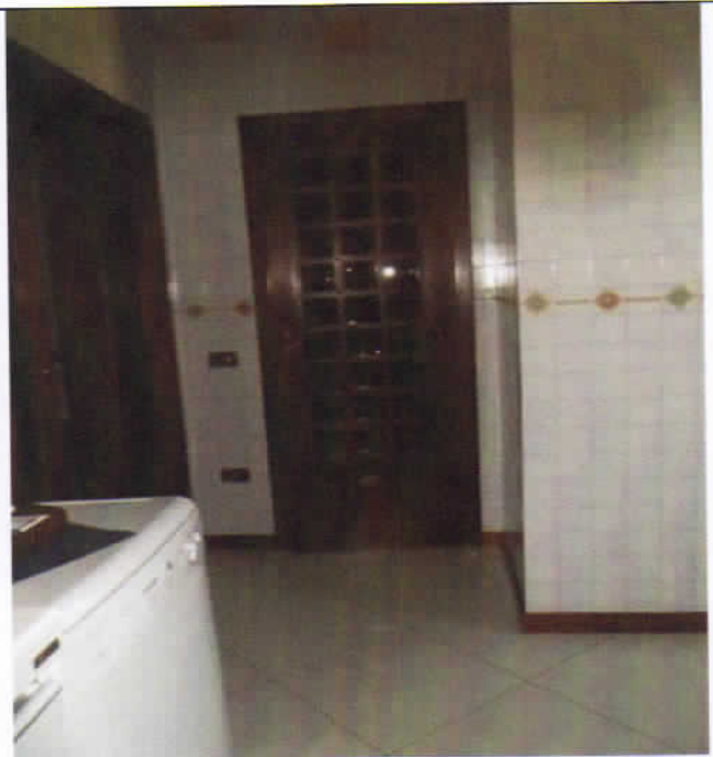
Foto 28 : Porta d'ingresso al vano scala di accesso al piano seminterrato
