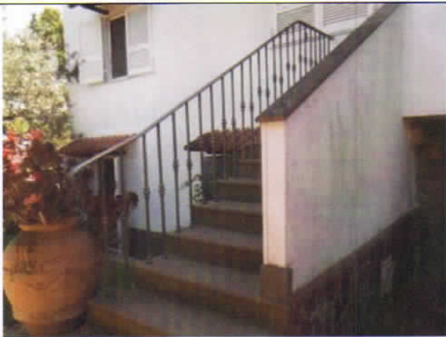
Foto 37 : Scala di accesso al terrazzo coperto tecnico
