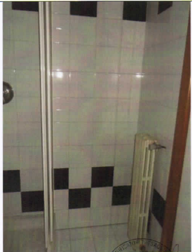
Foto 56 : Particolare del servizio igienico
