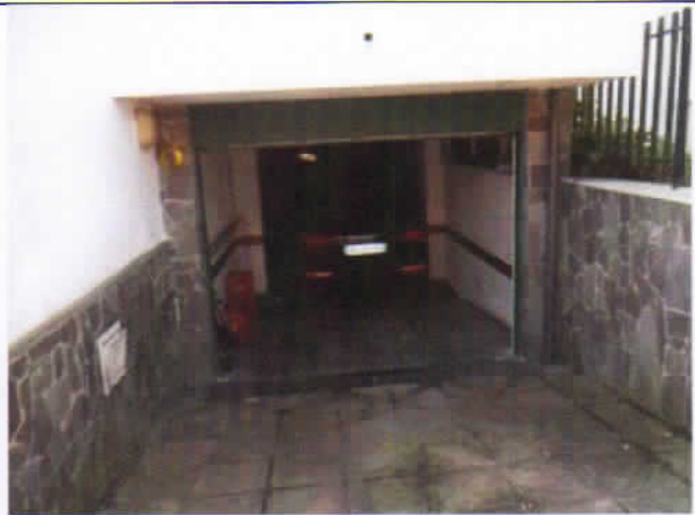
Foto 38 : Accesso al garage
