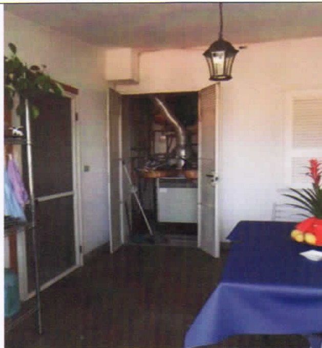
Foto 36 : Terrazzo coperto, porta di accesso al piano seminterrato e vano tecnico
