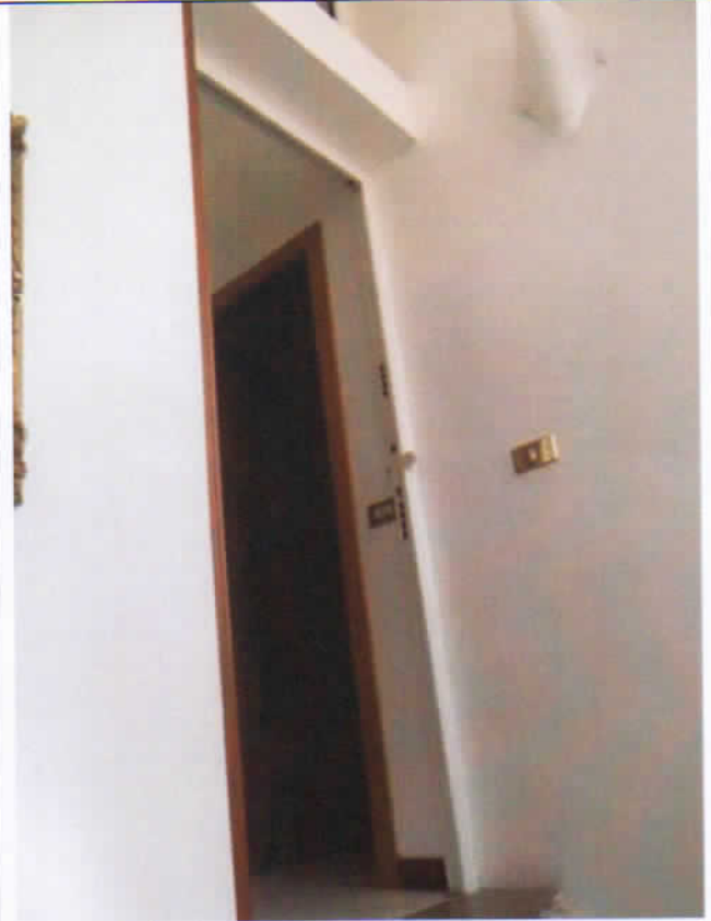
Foto 74 : Accesso al primo piano con porta blindata
