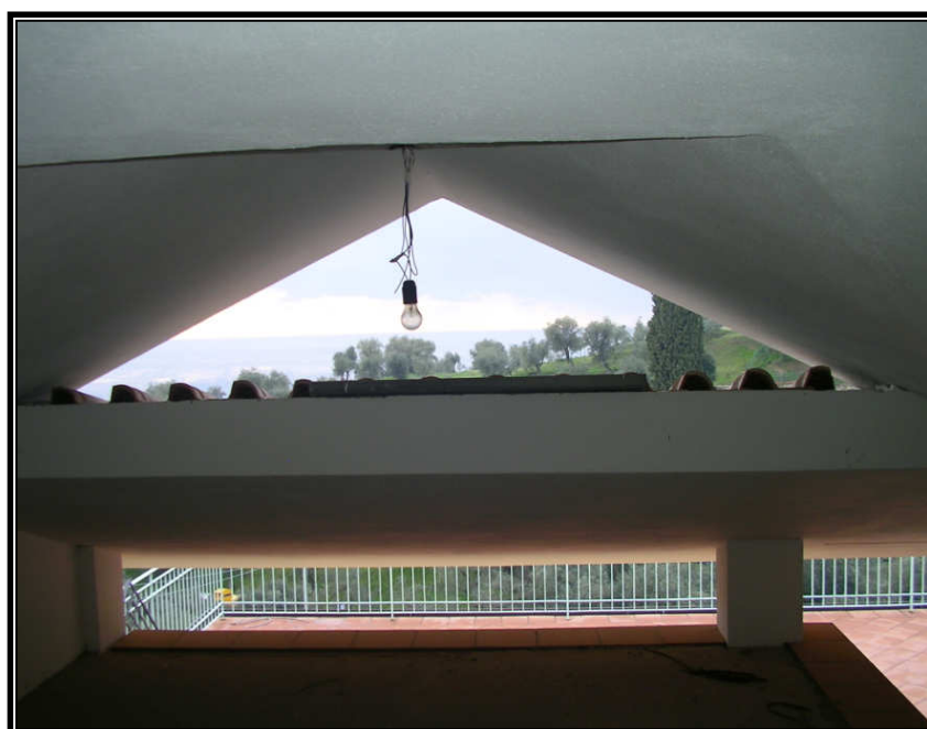
FOTO N. 23 PARTICOLARE INTERNO - SOTTOTETTO
