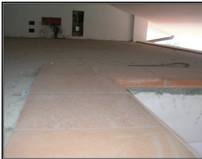
FOTO N. 22 PARTICOLARE INTERNO - SOTTOTETTO
