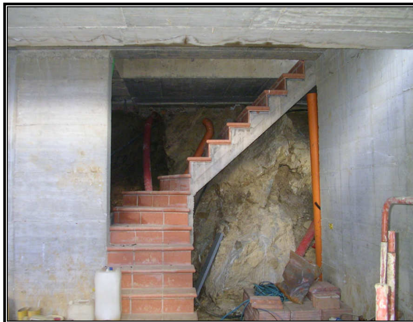
FOTO N. 5 VEDUTA INTERNA – PARTICOLARE SCANNAFOSSO
