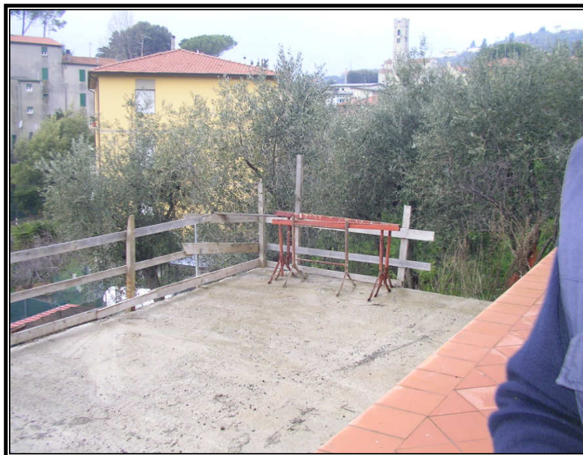
FOTO N. 8 VEDUTA ESTERNA COPERTURA PIANO INTERRATO
