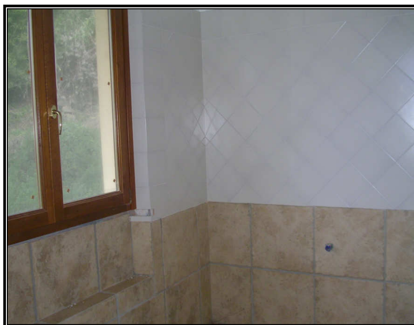
FOTO N. 15 PARTICOLARE INTERNO - CUCINA
