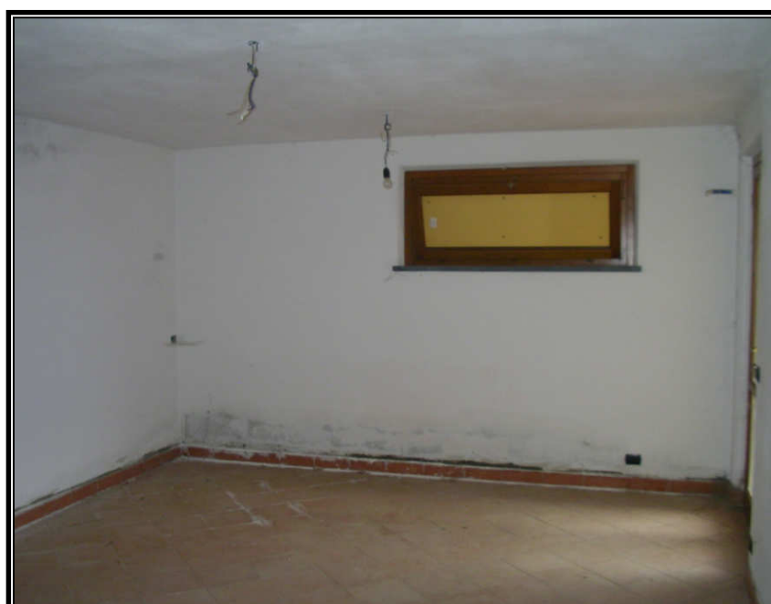
FOTO N. 10 PARTICOLARE INTERNO - SEMINTERRATO
