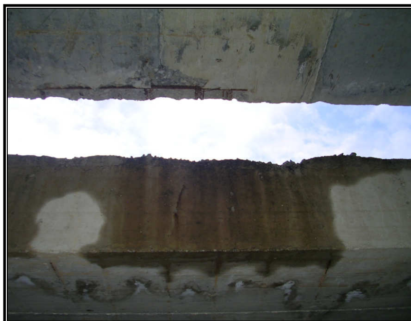
FOTO N. 6 VEDUTA ESTERNA – PARTICOLARE SCANNAFOSSO
