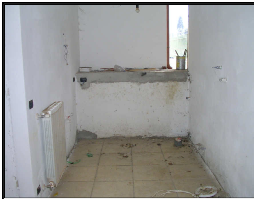
FOTO N. 11 PARTICOLARE INTERNO - SEMINTERRATO
