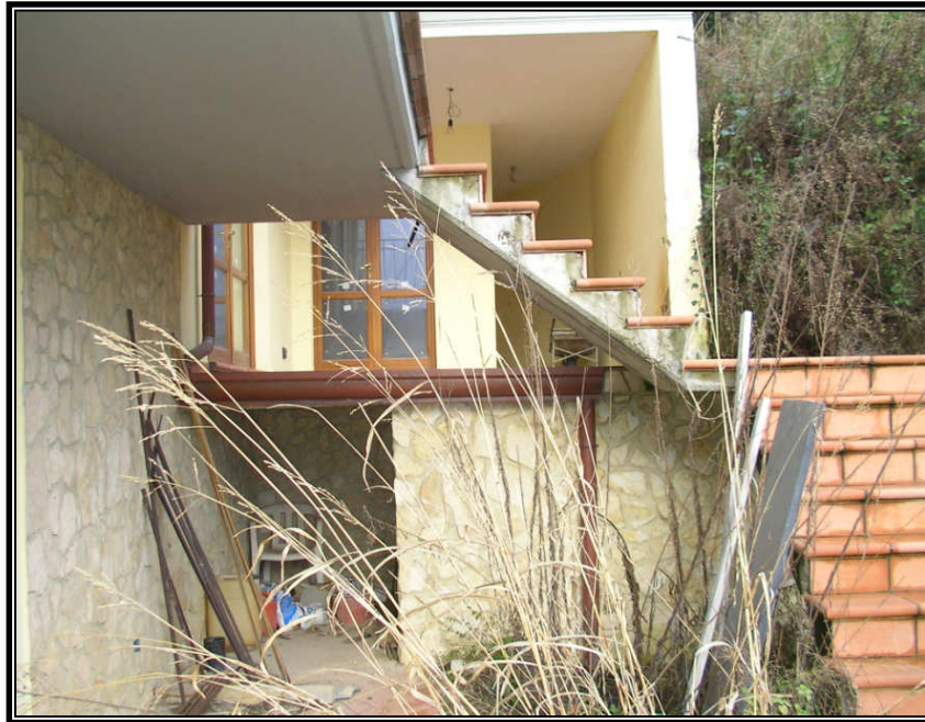
FOTO N. 7 VEDUTA INTERNA – PARTICOLARE SCALE ESTERNE
