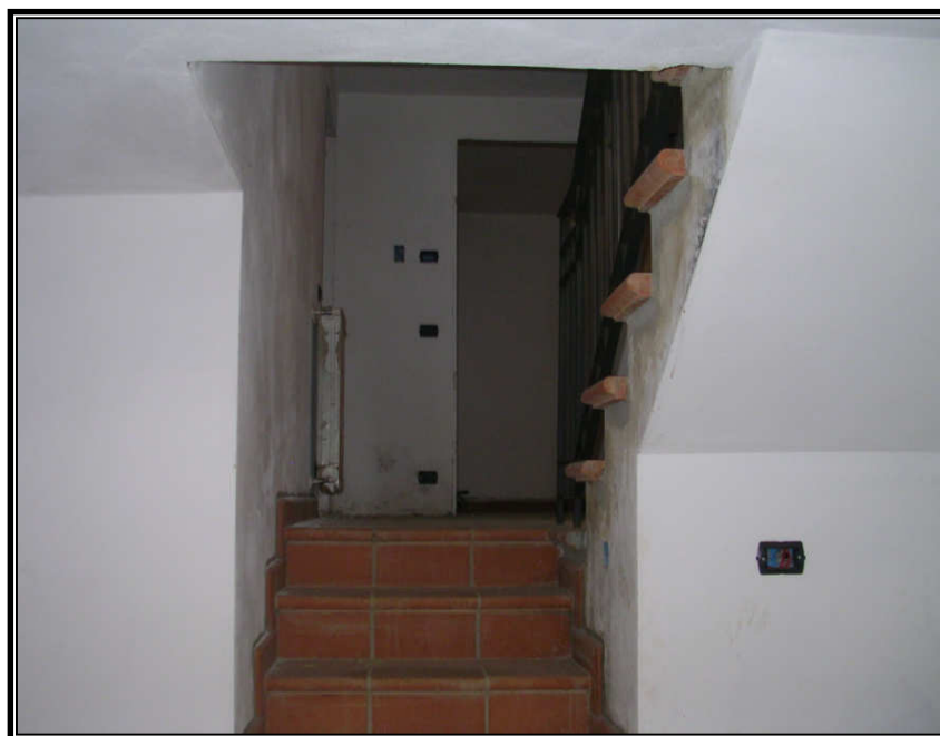
FOTO N. 9 PARTICOLARE INTERNO – SCALE INTERNE
