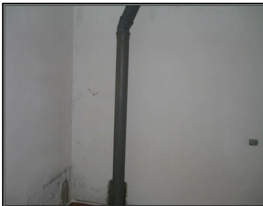
FOTO N. 12 PARTICOLARE INTERNO - SEMINTERRATO
