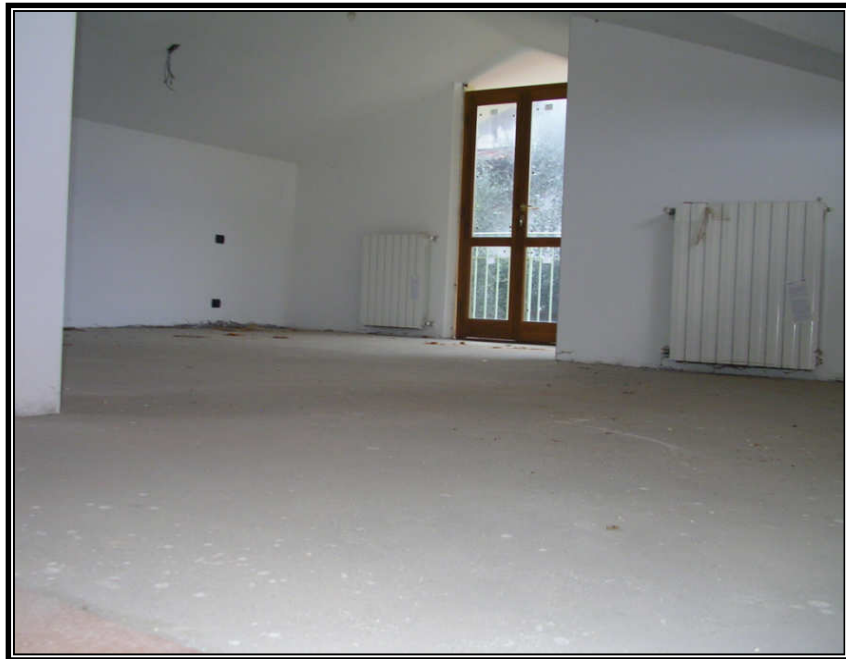
FOTO N. 21 PARTICOLARE INTERNO - SOTTOTETTO
