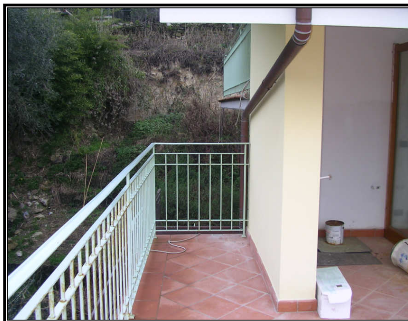
FOTO N. 19 PARTICOLARE INTERNO - TERRAZZO
