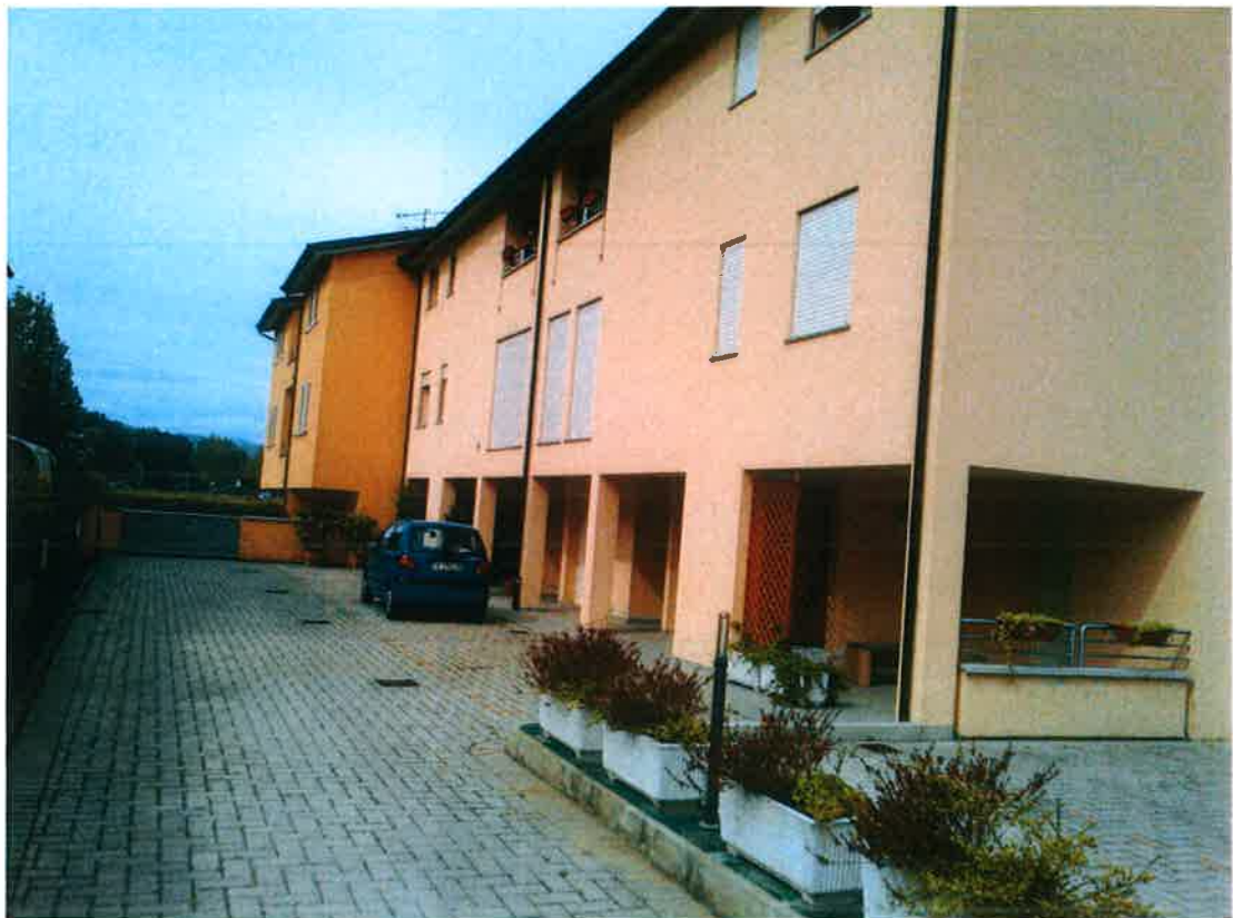
VISTA LATO OVEST FABBRICATO APPARTAMENTI FRONTE RETRO
