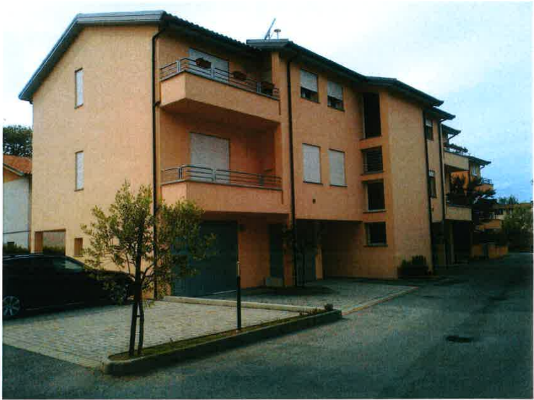
VISTA LATO SUD-EST LATO INGRESSO APPARTAMENTO ALTRO FABBRICATO
