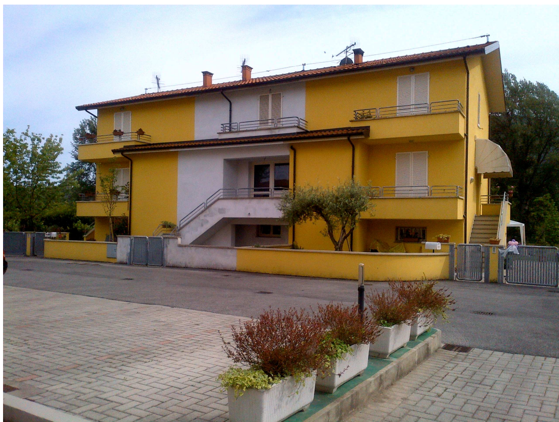
VISTA LATO NORD FABBRICATO VILLETTA A SCHIERA
