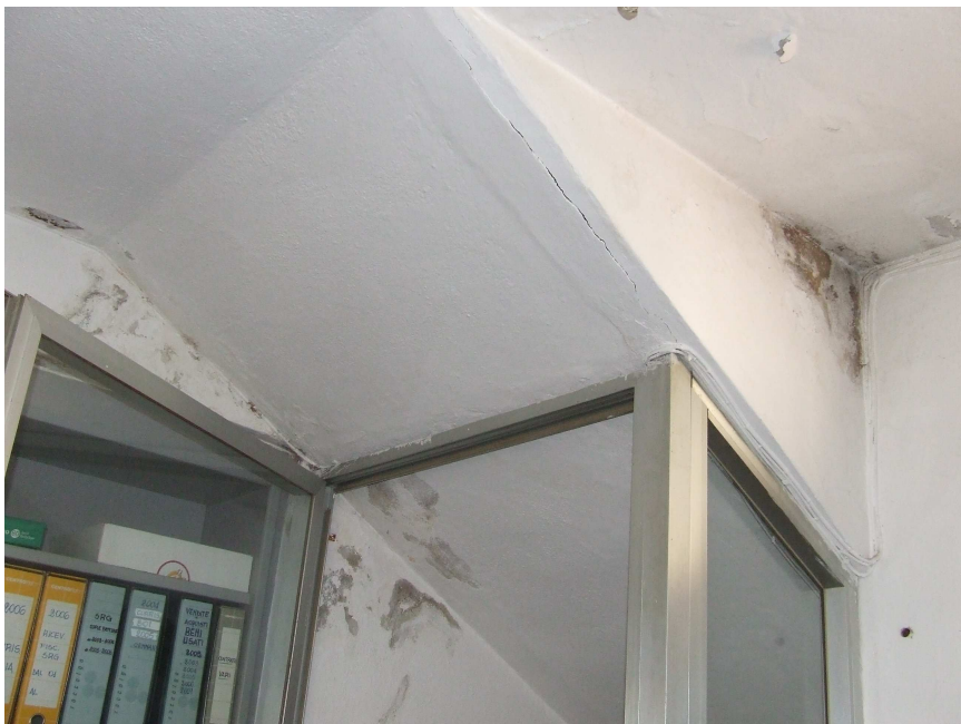
2) Infiltrazioni di umidità dalla rampa di scale esterna
