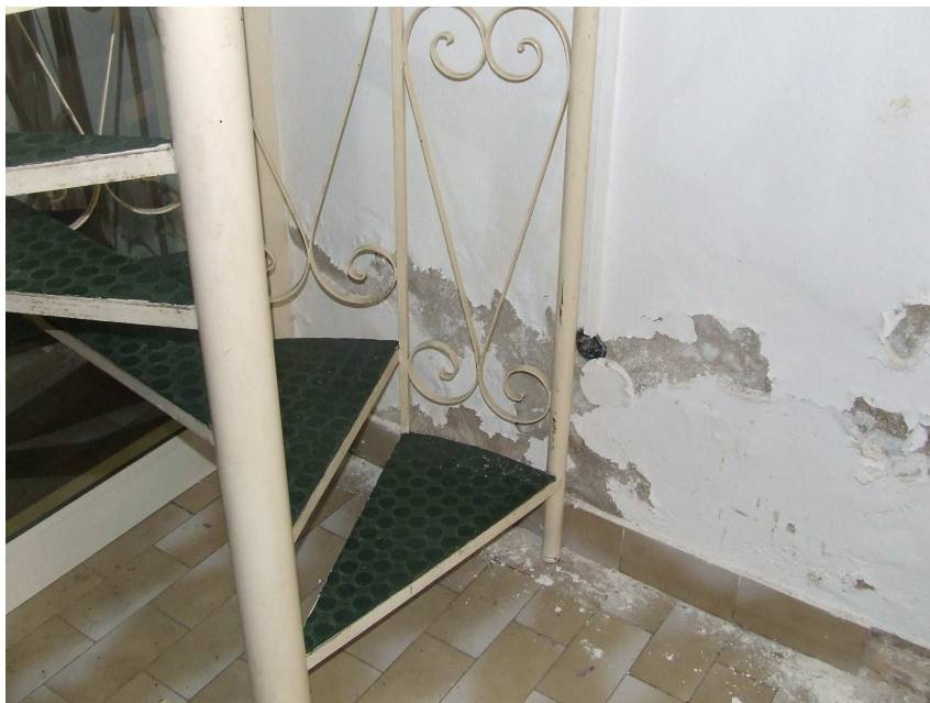
3) Umidità di risalita alla base della scala in ferro per il piano ammezzato
