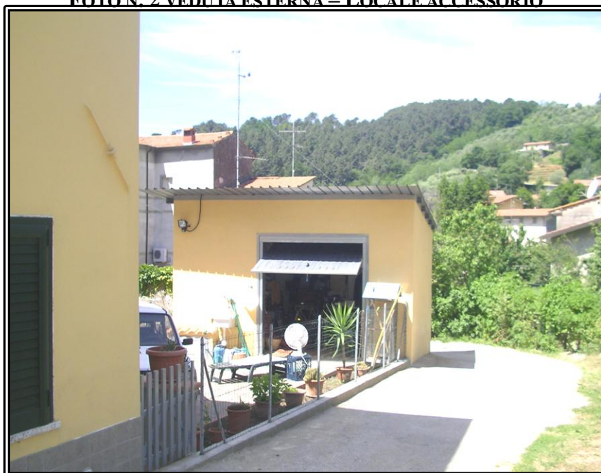
FOTO N. 2 VEDUTA ESTERNA – LOCALE ACCESSORIO
