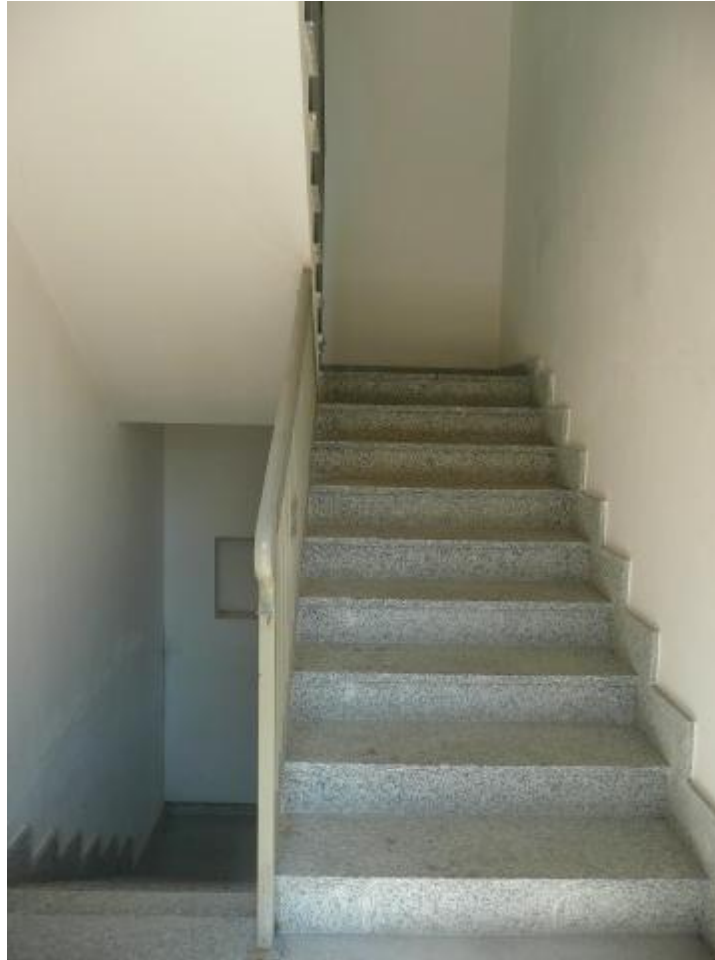
Dettaglio scala comune
