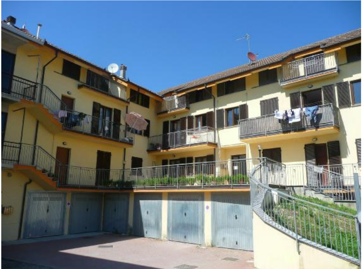
Veduta di insieme del condominio
