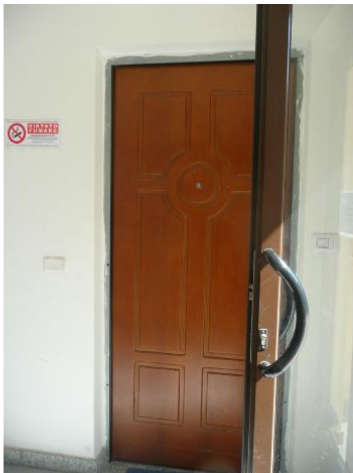
Portoncino ingresso appartamento
