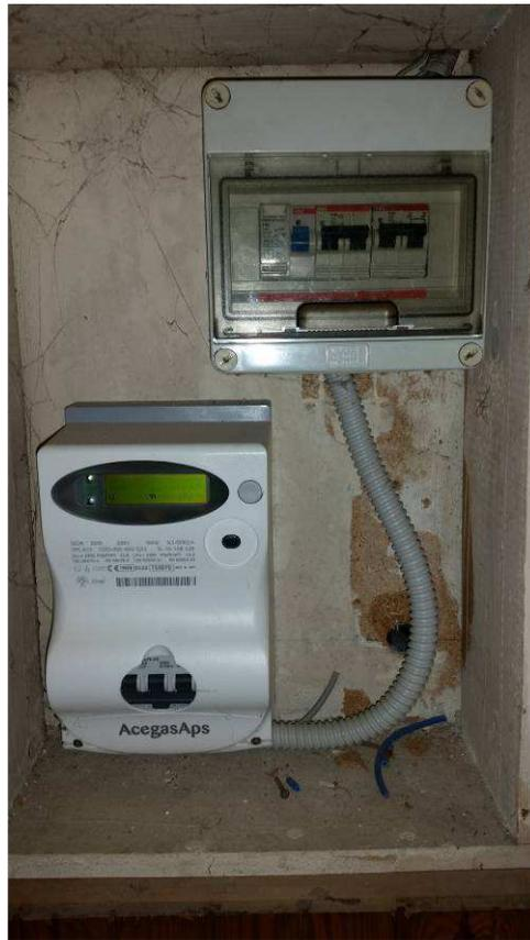
*FOTO 15- quadro e contatore elettrico*
