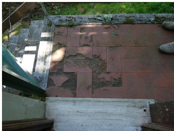
Particolare pavimento terrazzino
