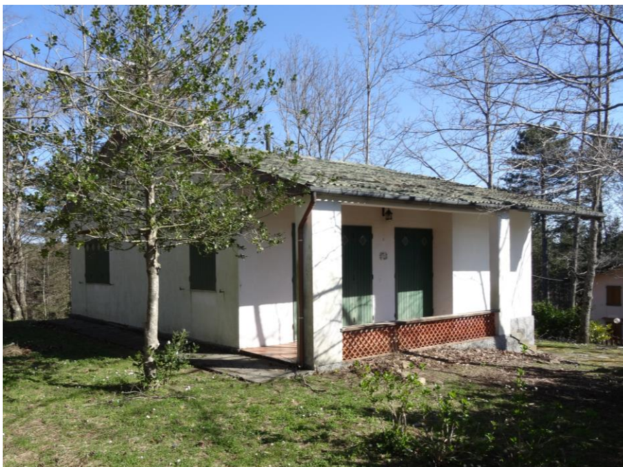
Particolare lati Sud ed Ovest
