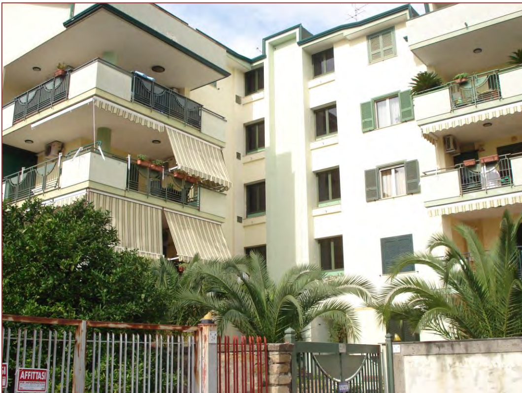
FOTO 2. PROSPETTO SUD DEL FABBRICATO (PARTICOLARE SCALA "A")
