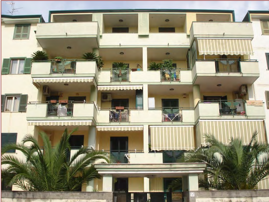
FOTO 1. PROSPETTO SUD DEL FABBRICATO (INGRESSO DA VIA PIEMONTE N. 38 - ACERRA)
