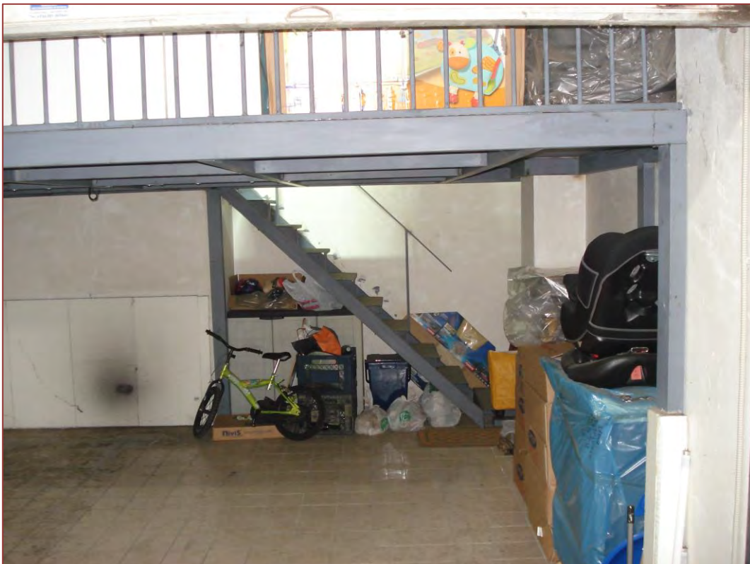
FOTO 14. BENE N. 2 - BOX (PARTICOLARE PEDANA METALLICA)
