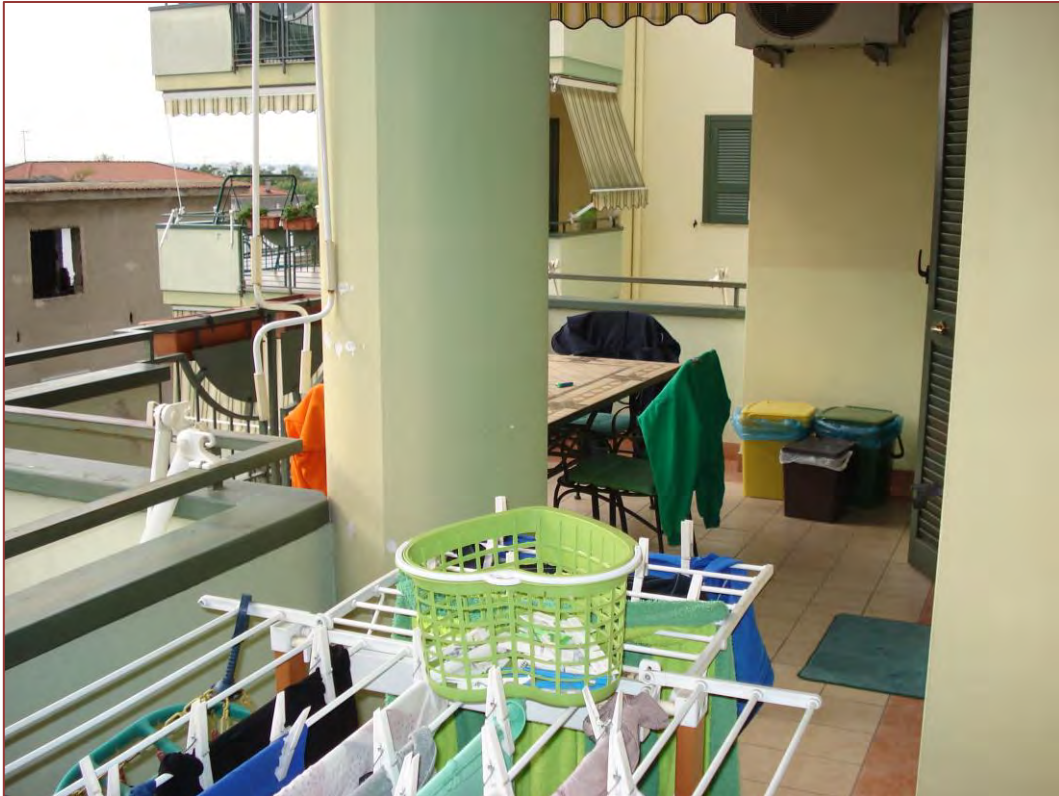
FOTO 9. BENE N. 1 - BALCONE PROSPETTO SUD
