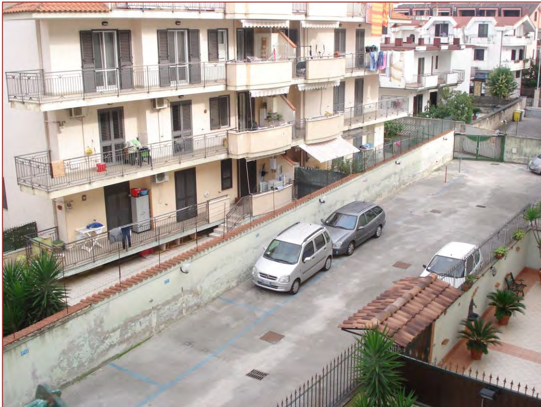
FOTO 11. BENE N. 1 – VEDUTA DA BALCONE PROSPETTO NORD
