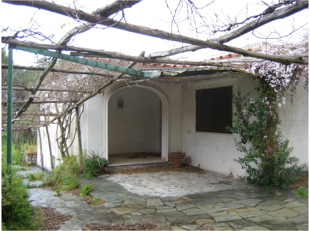
fig 1 – portico lato ingresso
