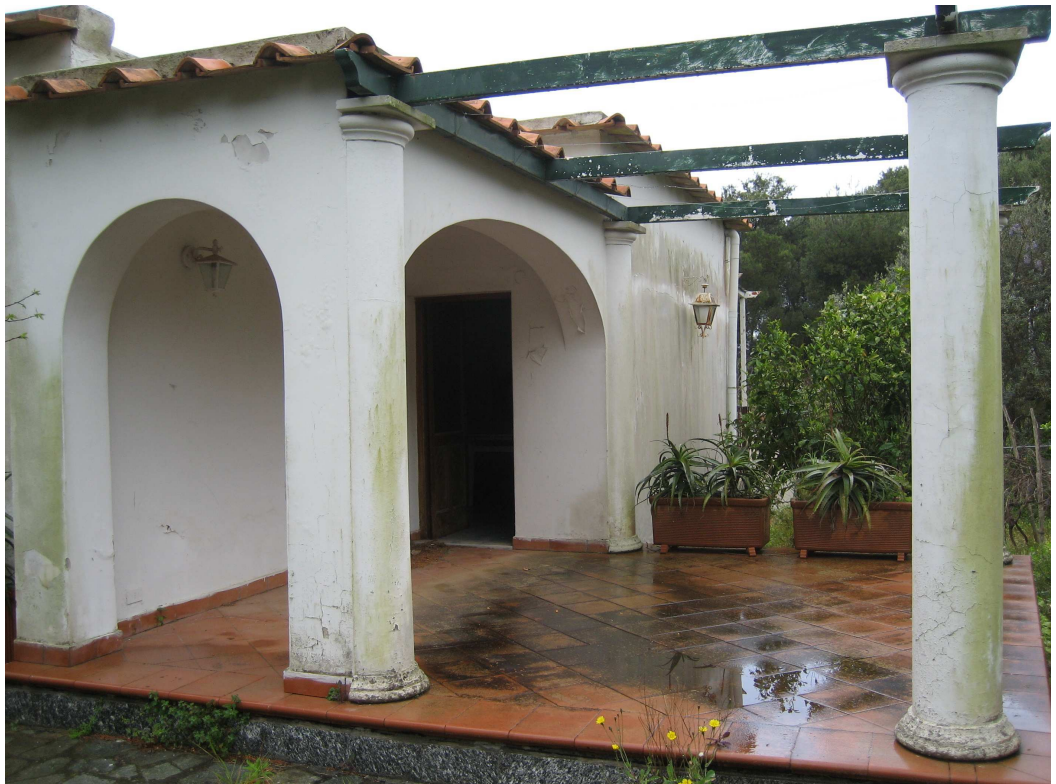
fig 2 - portico lato soggiorno-pranzo
