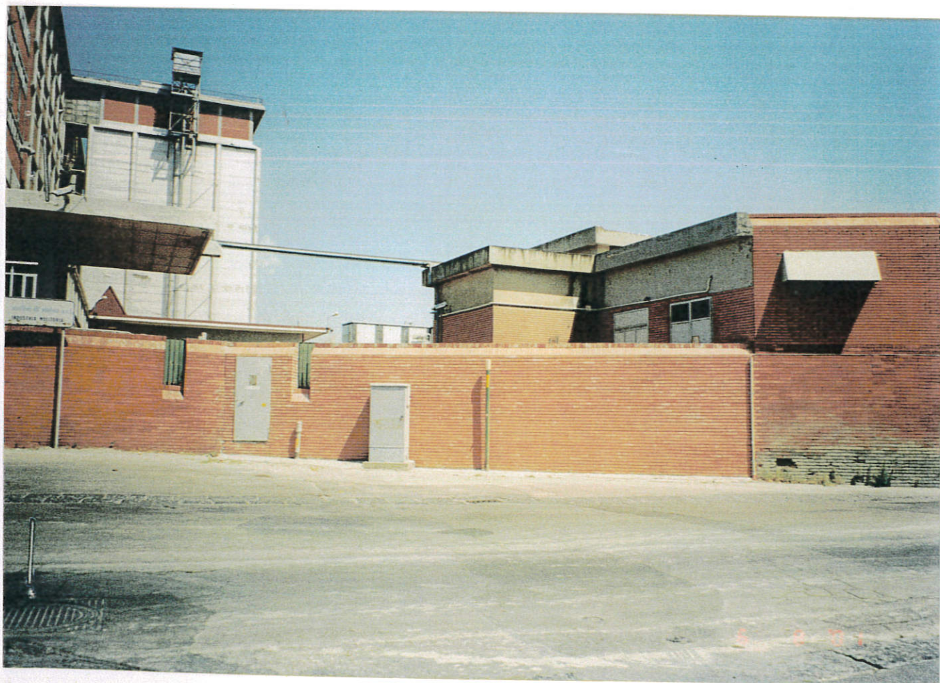
FOTO n° 8: Muro di cinta su traversa Varo
