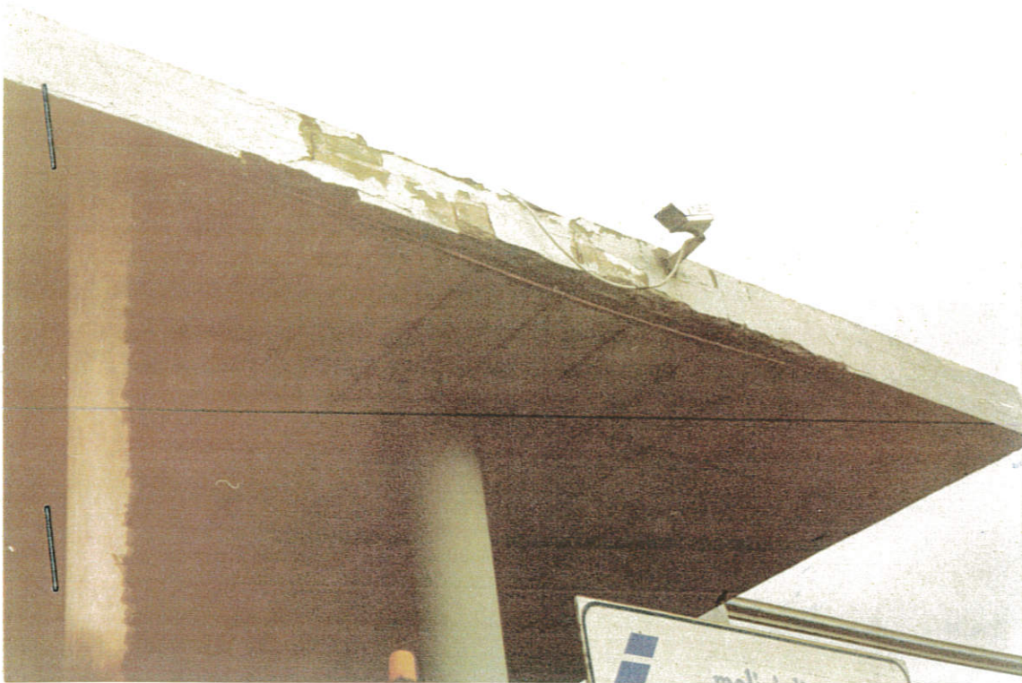
FOTO n° 9: Frontalino della pensilina d'ingresso ammalorato
