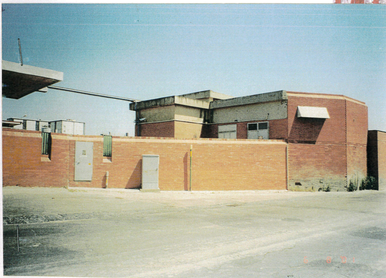
FOTO n° 12 : Muro di recinzione perimetrale rifatto
