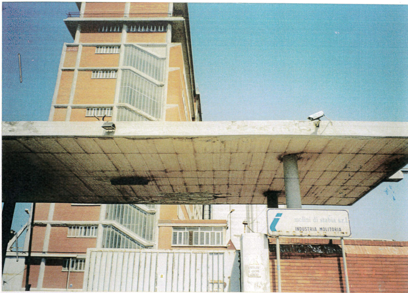
FOTO n° 5 : Pensilina d'ingresso allo stabilimento
