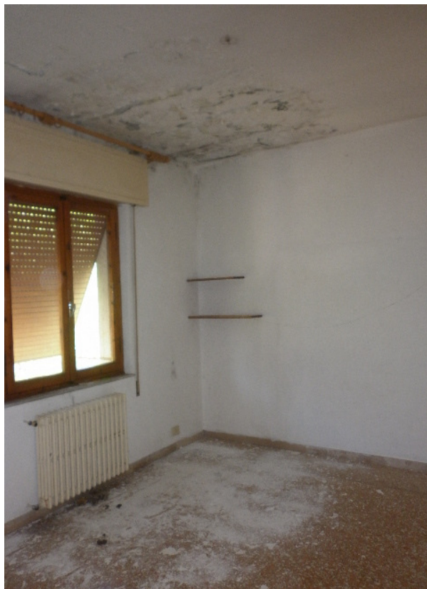
Particolare (1) infiltrazioni di umidità presenti all'interno dell'U.I. (mappale 4536 sub. 7)
