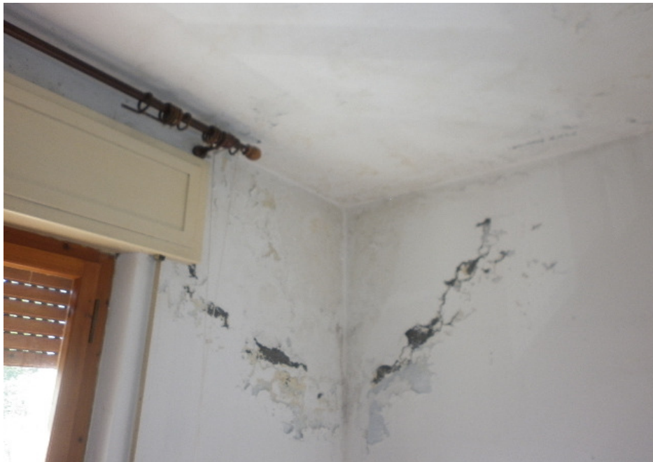
Particolare (3) infiltrazioni di umidità presenti all'interno dell'U.I. (mappale 4536 sub. 7)
