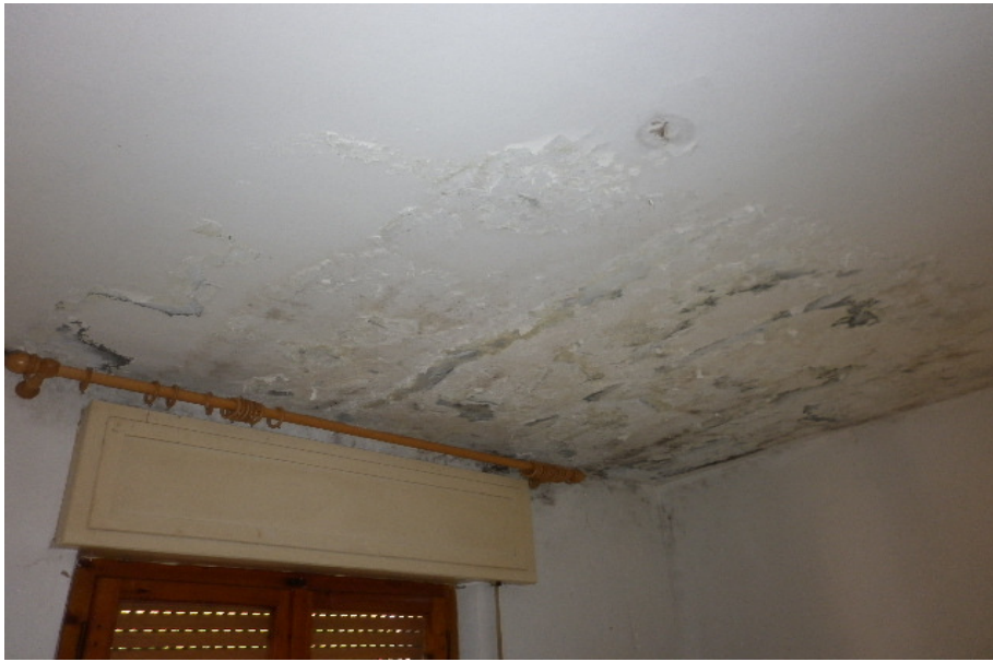
Particolare (2) infiltrazioni di umidità presenti all'interno dell'U.I. (mappale 4536 sub. 7)
