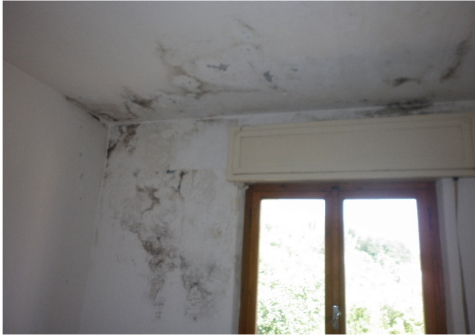
Particolare (4) infiltrazioni di umidità presenti all'interno dell'U.I. (mappale 4536 sub. 7)
