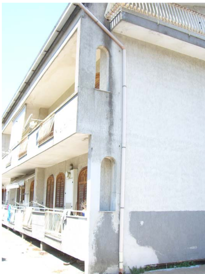
Foto n. 2 vista del fabbricato a sud
