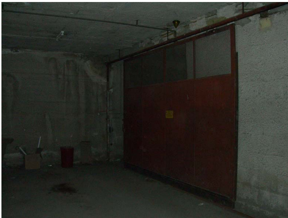
Foto n. 29 ingresso deposito dal viale comune
