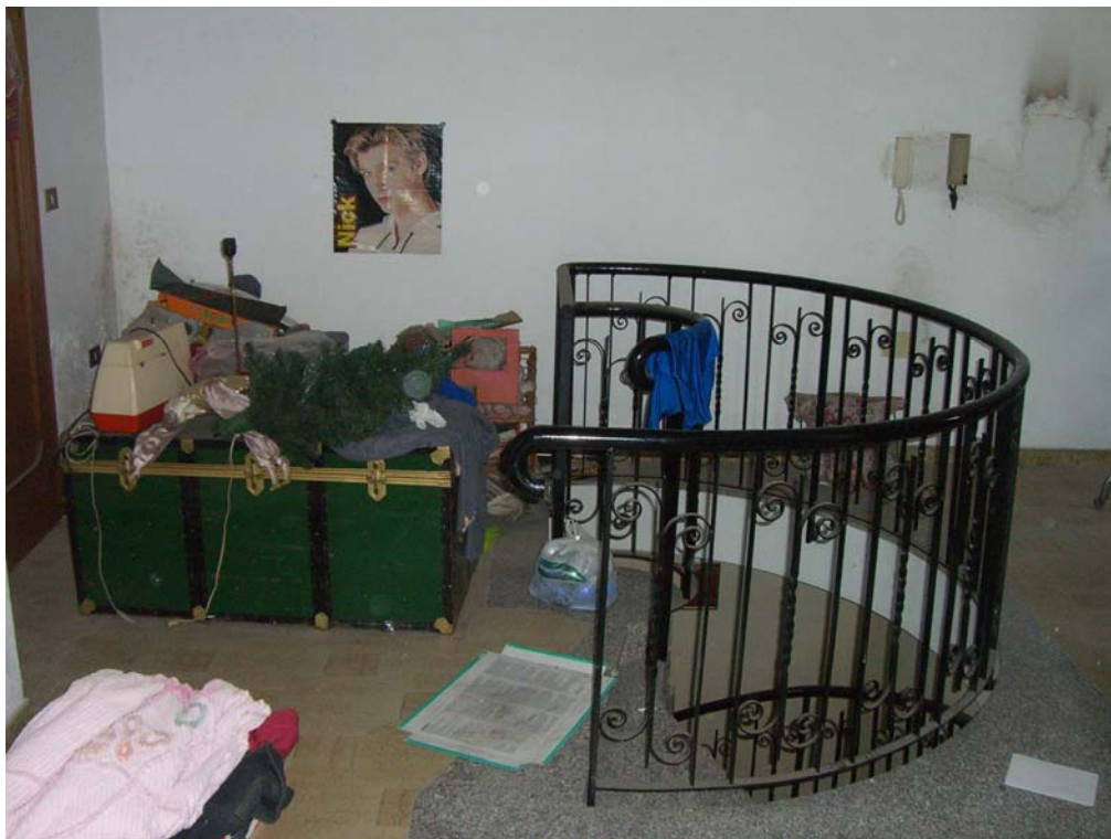
Foto n. 20 terminale scala secondo piano
