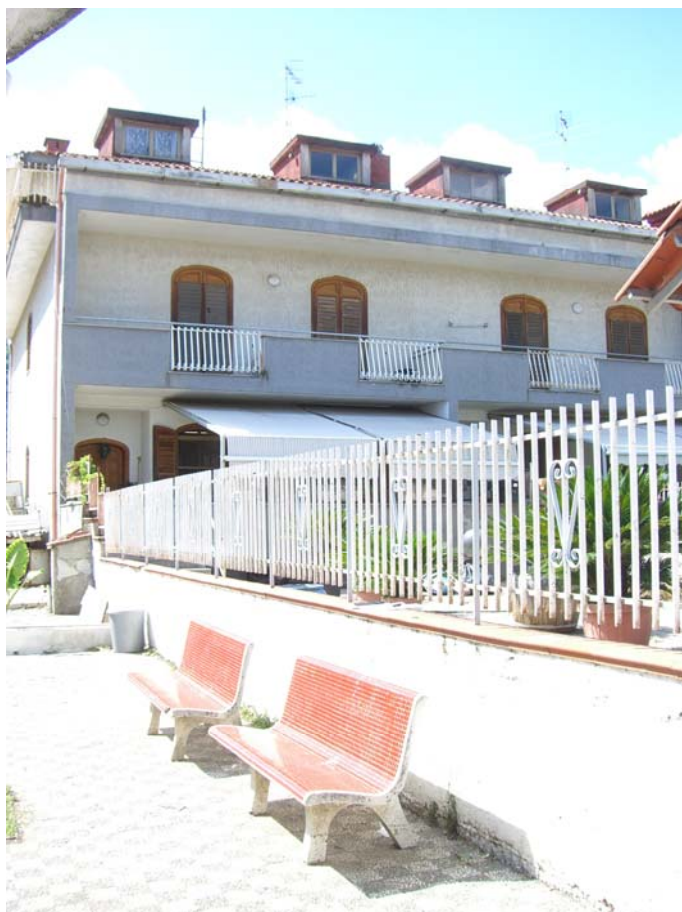
Foto n. 1 vista del fabbricato a nord
