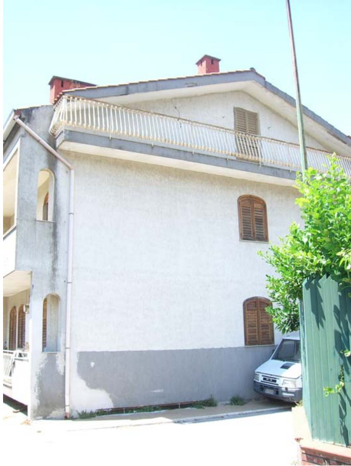
Foto n. 3 vista del fabbricato a est
