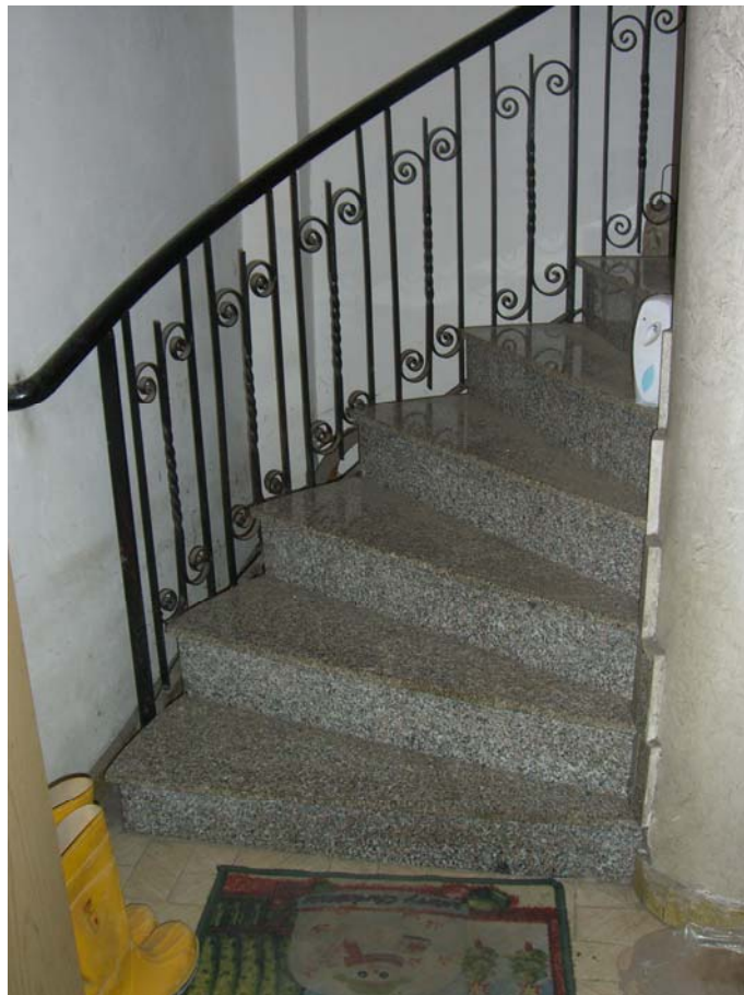
Foto n. 34 inizio della scala interna di collegamento dal deposito
