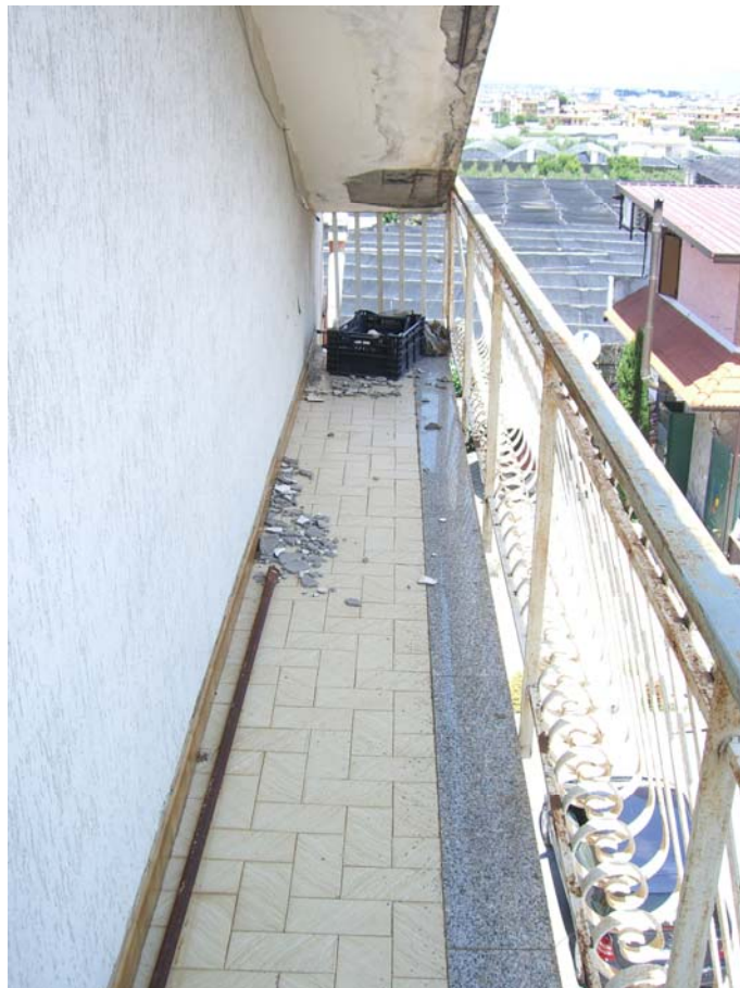
Foto n. 28 balcone secondo piano
