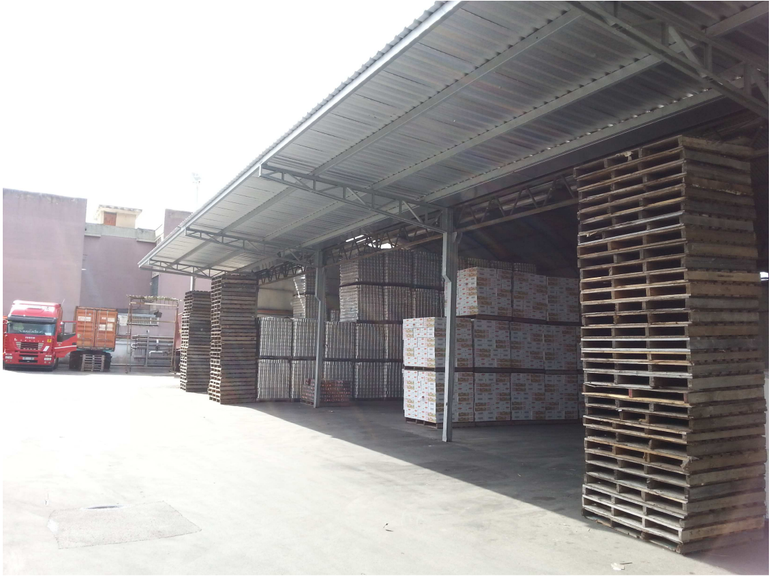
LOTTO N°1 - FOTO N°1
