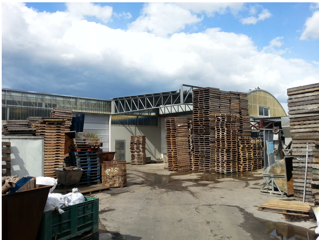
LOTTO N°2 - FOTO N°3
