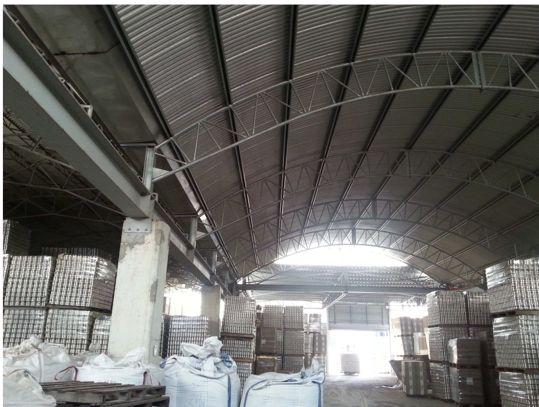
LOTTO N°2 - FOTO N°8
