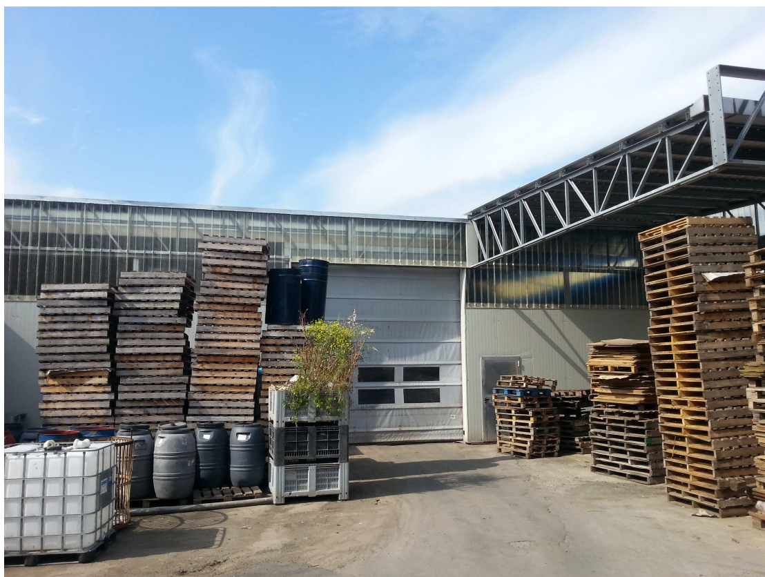
LOTTO N°2 - FOTO N°4
