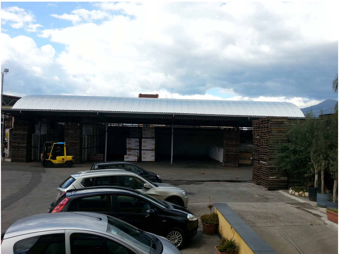
LOTTO N°1 - FOTO N°2
