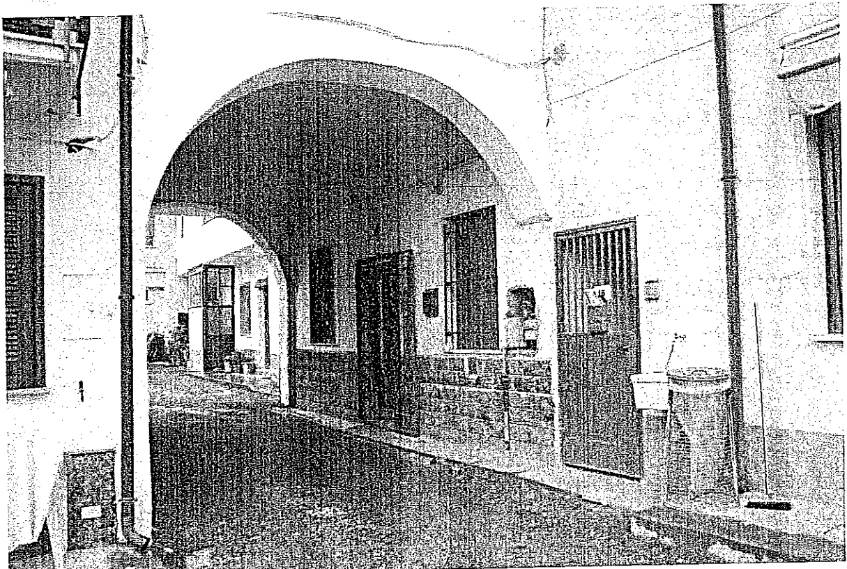
RGE 1048 del 2009 | Consorzio Edilizia Sociale Italia ONLUS Parabiago, Frazione Villastorta, piazza Indipendenza n.° 2 Ingresso dal cortile interno
