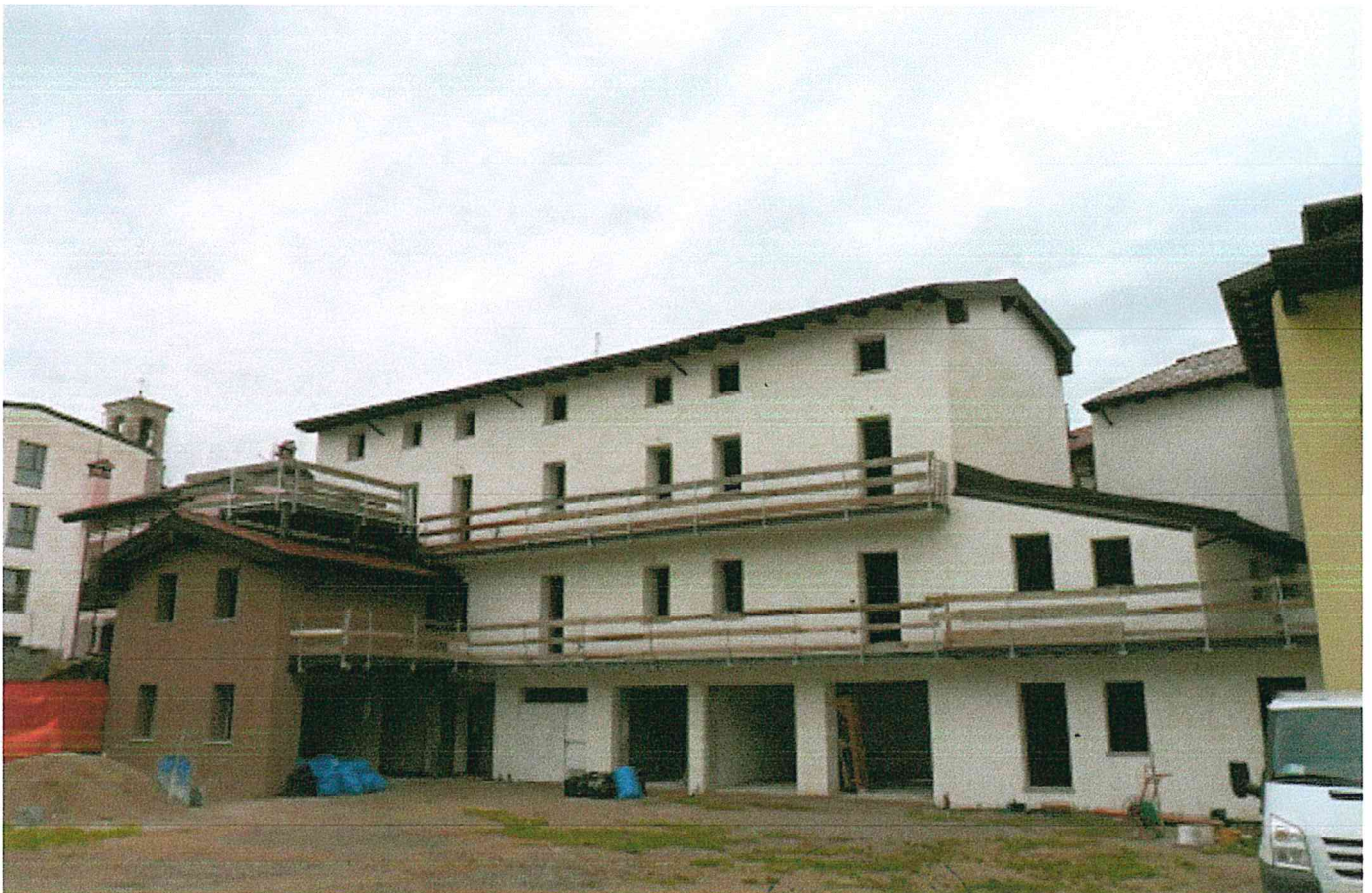
prospetti sud ed est corpo addossato confine ovest particella, prospetto sud corpo trasversale, corte condominiale
