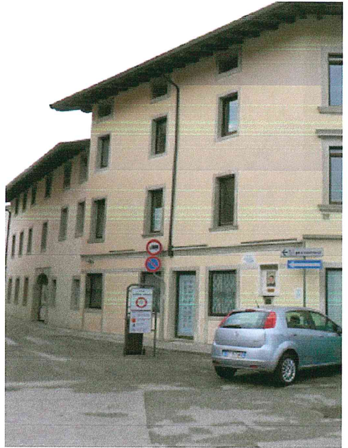
Prospetto est, Via Tomadini
