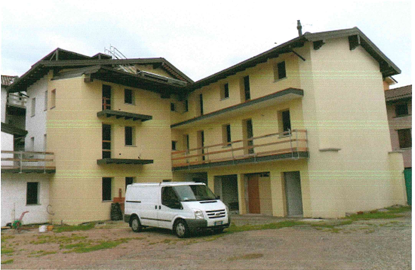
Prospetti ovest e sud primo tratto corpo trasversale, prospetti ovest e sud corpo parallelo Via Tomadini, corte condominiale
