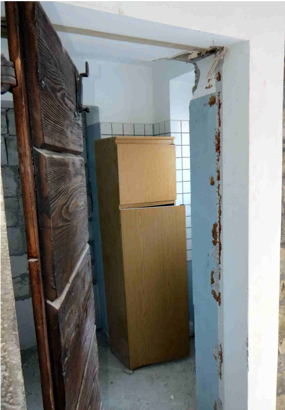
F13 VISTA VERSO IL LOCALE EX WC
