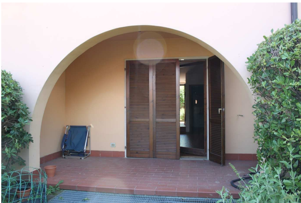
Foto n. 13. Piano Terra. Porticato
