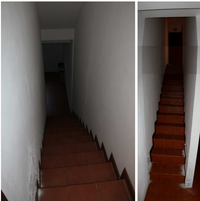
Foto n. 24-25. Piano S1. Scala di collegamento al piano S1
