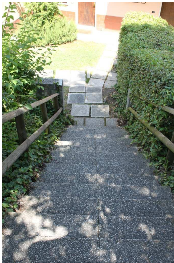
Foto n. 4-5. Ingresso pedonale comune
