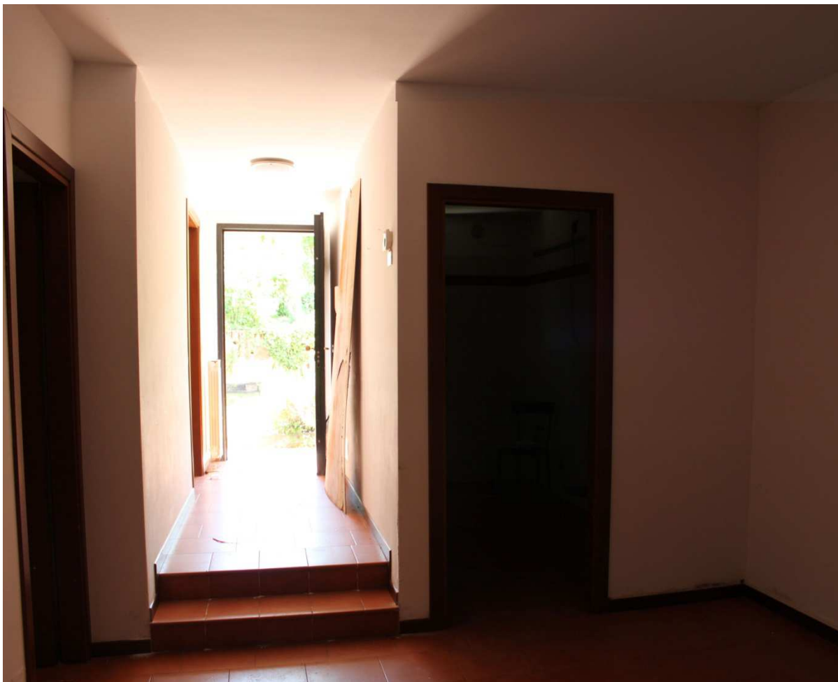
Foto n. 9. Piano Terra. Vano ingresso
