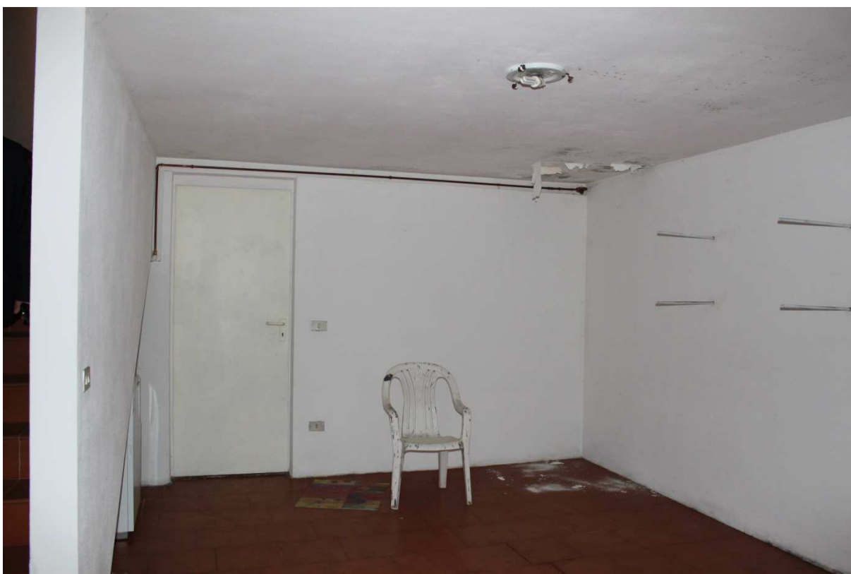
Foto n. 26. Piano S1. Cantina
