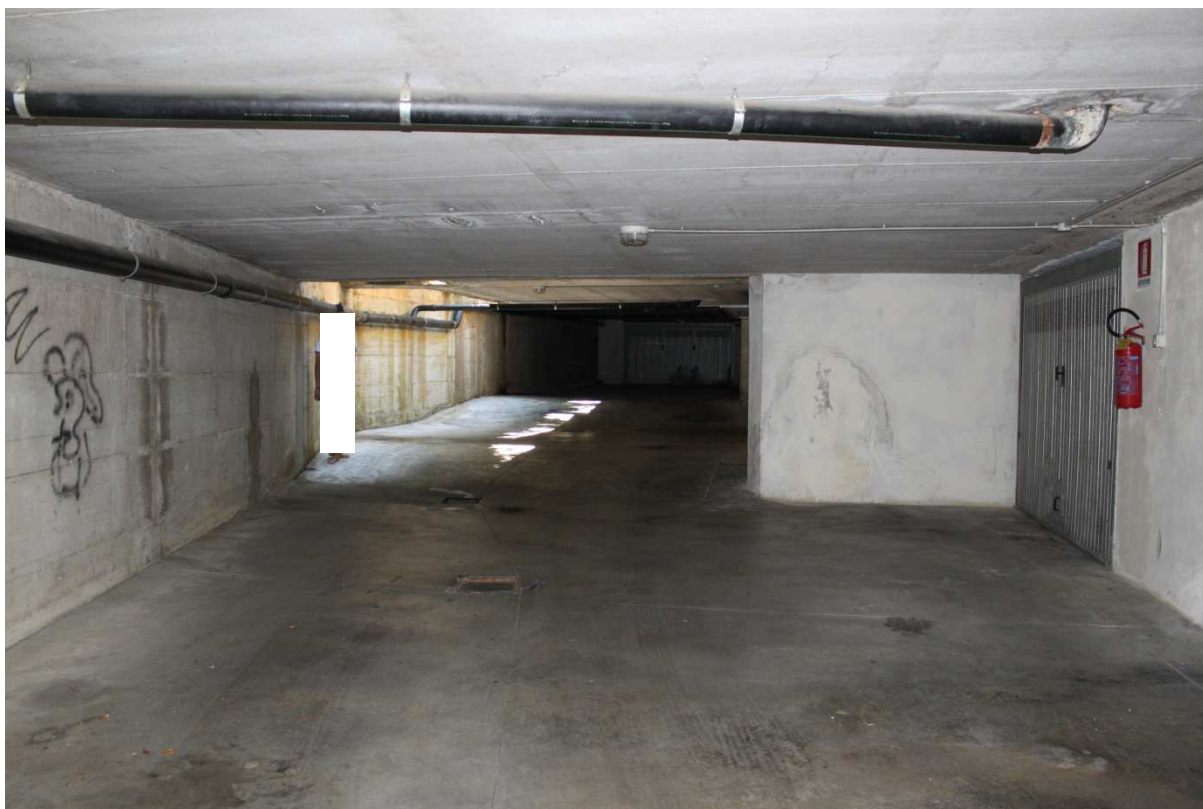
Foto n. 31. Corsia di manovra comune
