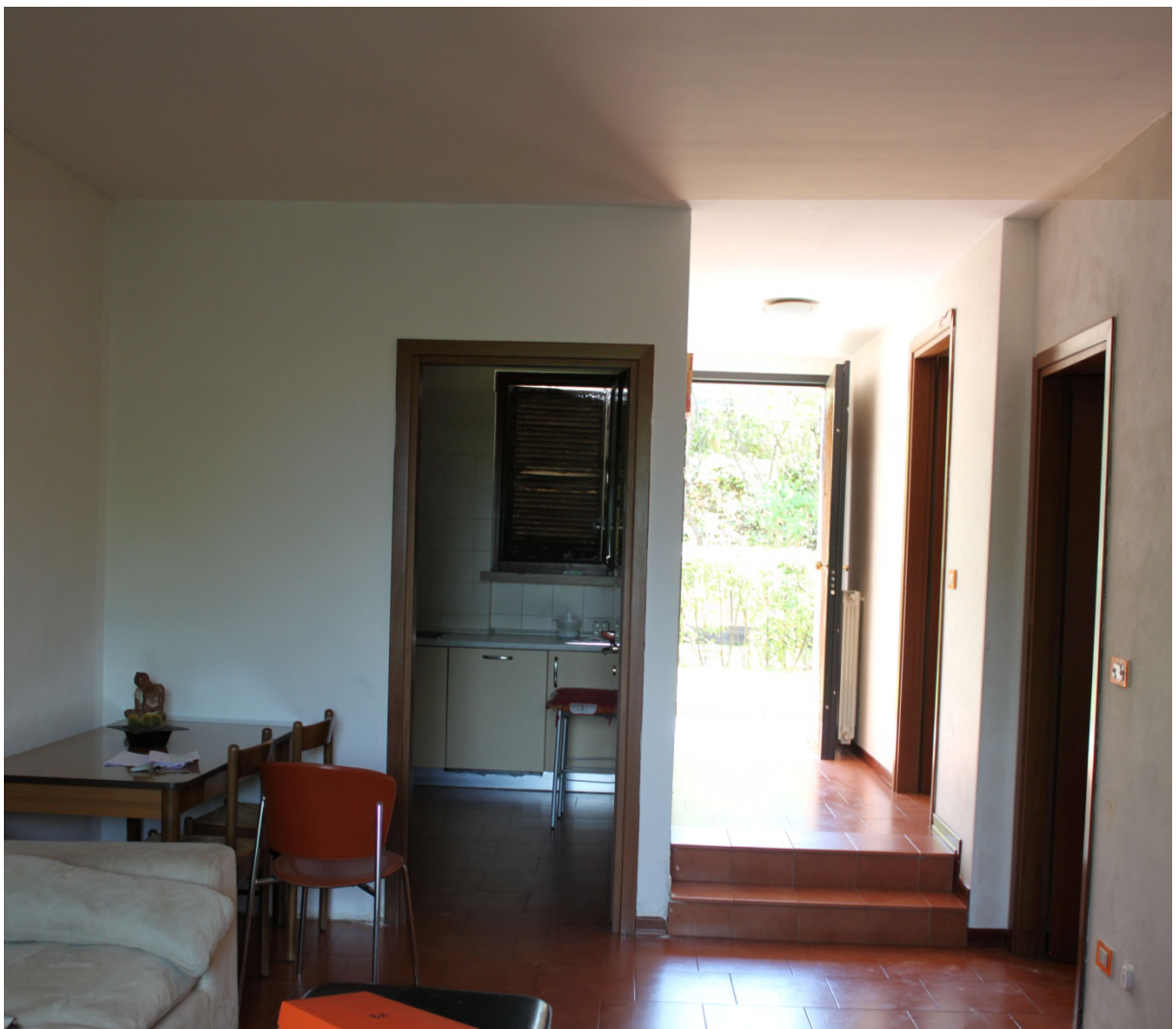
Foto n. 11. Piano Terra. Vano ingresso
