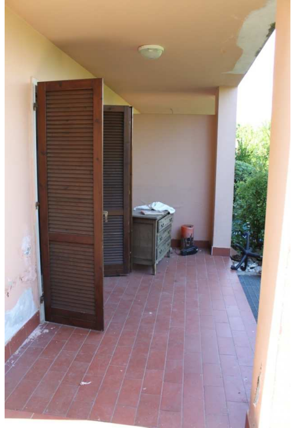
Foto n. 15-16. Piano Terra. Porticato
