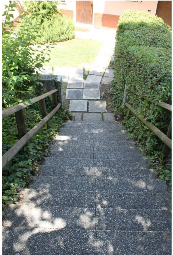
Foto n. 4-5. Ingresso pedonale comune
