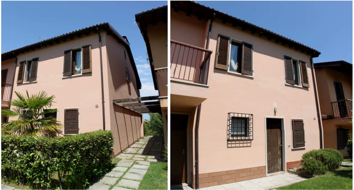
Foto n. 9-10. Villetta a schiera al piano S1-T-1
