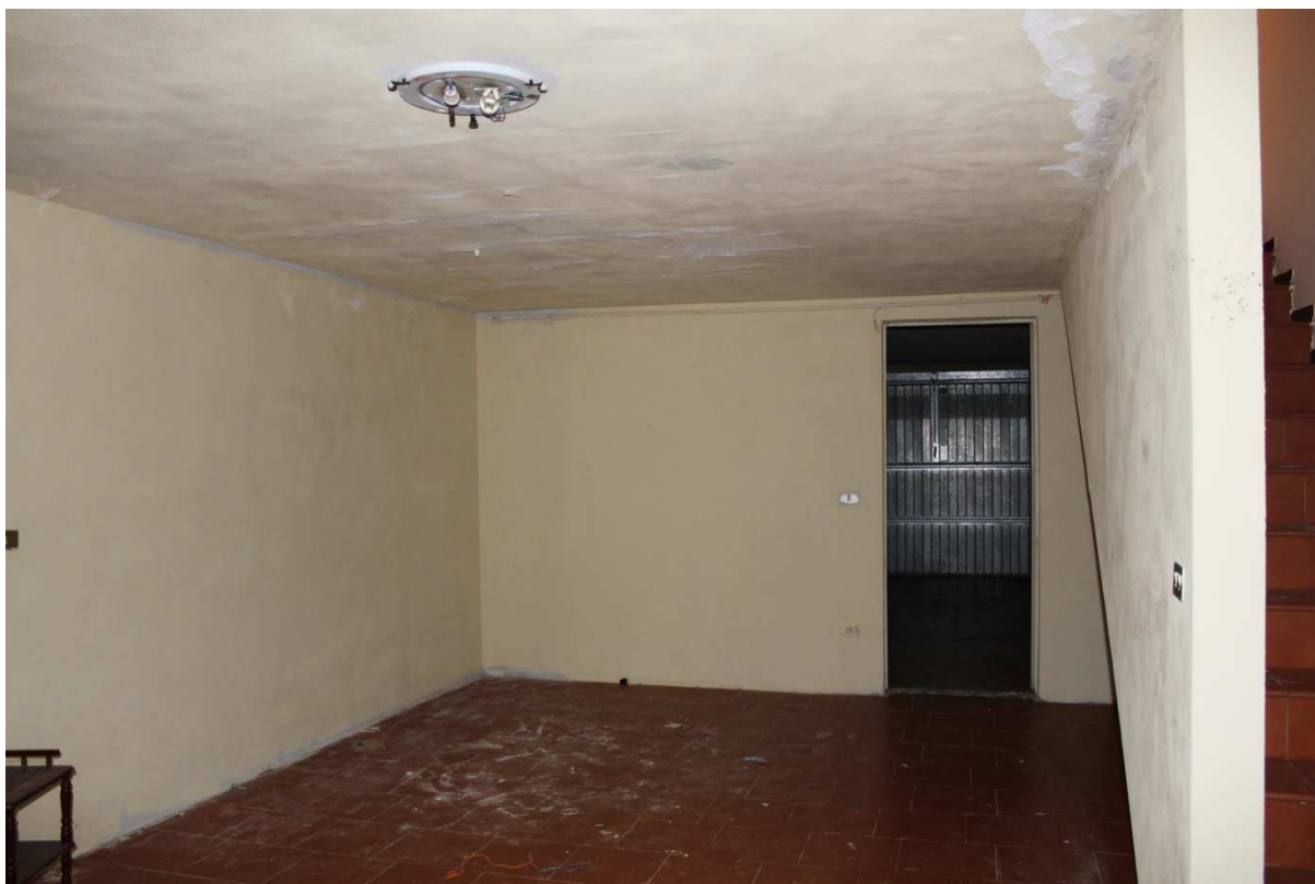
Foto n. 33. Piano S1. Cantina
