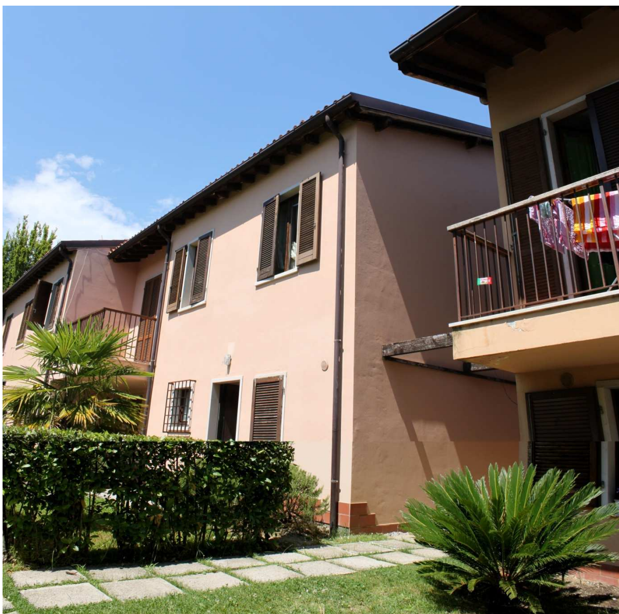
Foto n. 8. Villetta a schiera al piano S1-T-1
