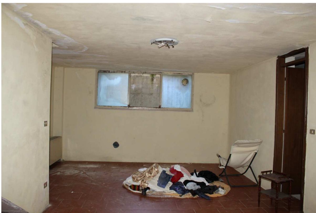
Foto n. 34. Piano S1. Cantina
