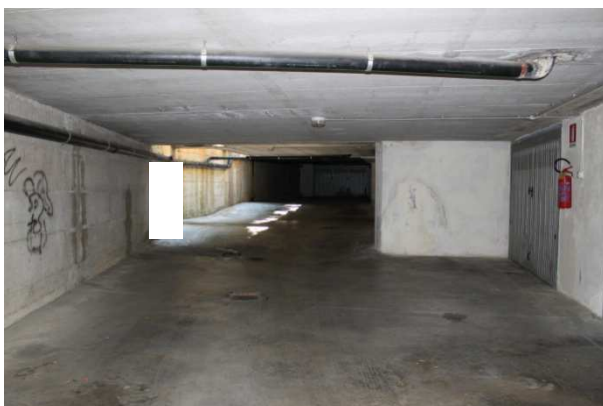
Foto n. 41. Corsia di manovra comune
