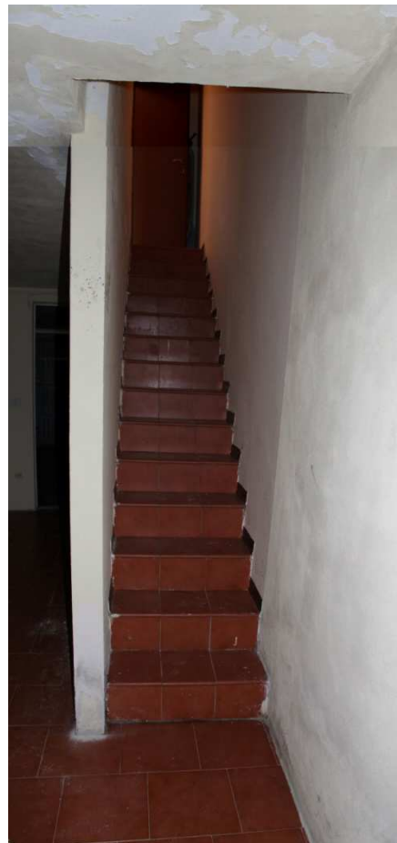
Foto n. 31-32. Piano S1. Scala di collegamento al piano S1
