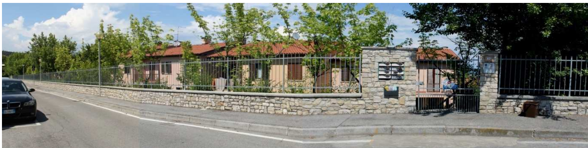
Foto n. 1. Villetta a schiera al piano S1-T-1 , sita in Polpenazze del Garda (BS) alla Via Don Francesco Mercanti n. 4. Complesso residenziale denominato "Golf Country Club"
