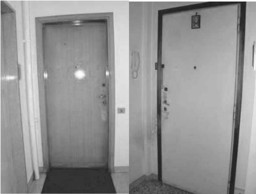
7. Vista della porta di accesso all'alloggio, dal pianerottolo e dall'interno.
