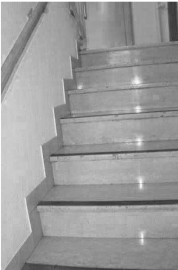
16. Vista delle scale condominiali.
