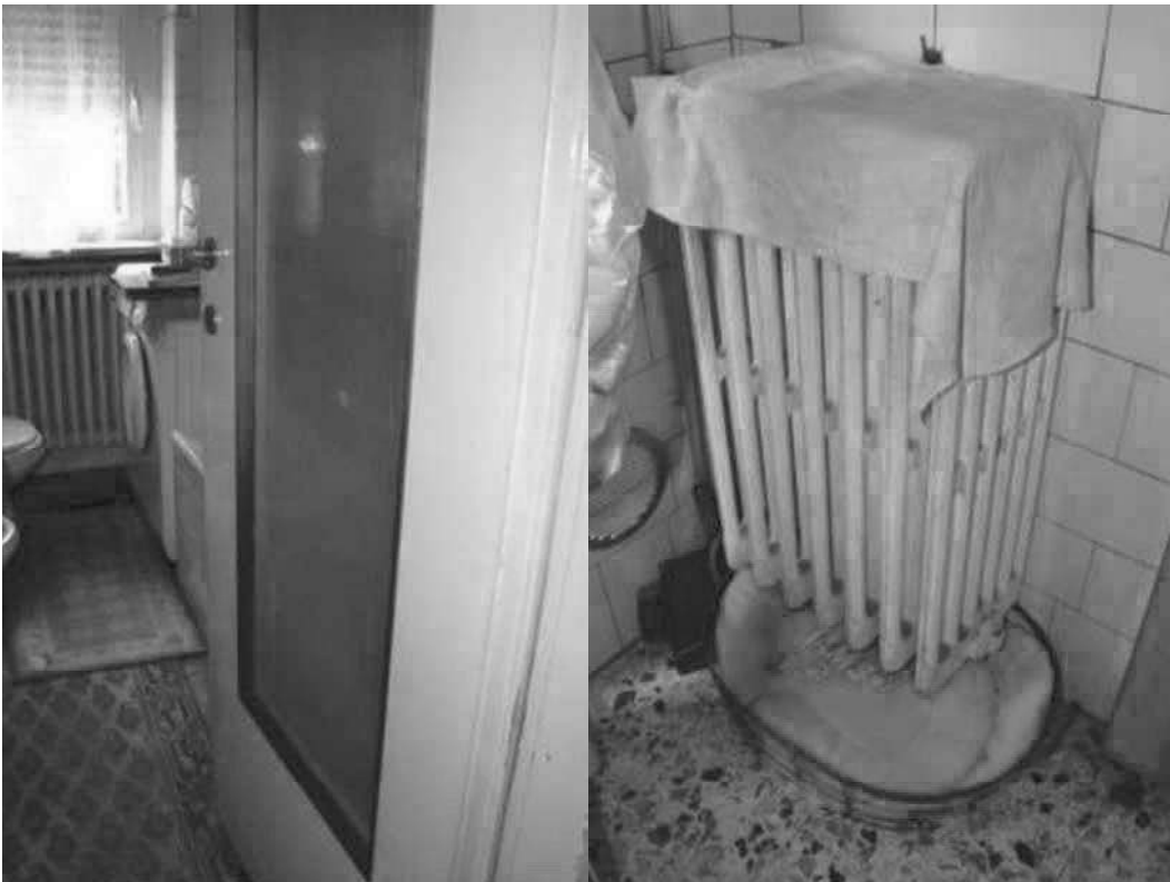
14. Vista del bagno e dettaglio del calorifero.
