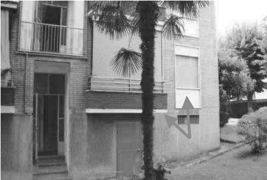
5. Vista del retro dell'edificio con indicati gli affacci dell'alloggio.
