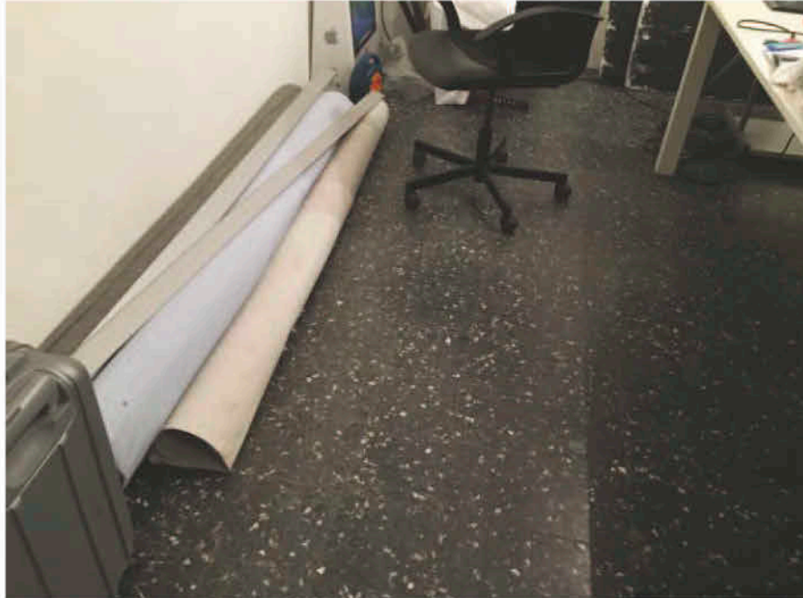
dettaglio pavimento (locali uffici)
