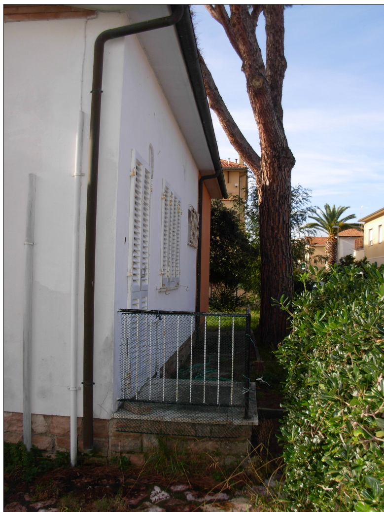
vista da corte interna - lato nord
