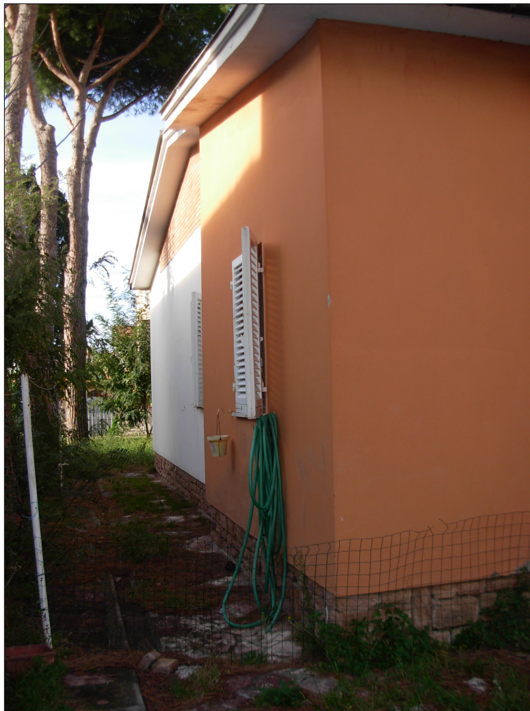
vista da corte interna - lato sud
