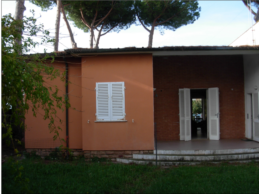
vista da corte interna - lato est
