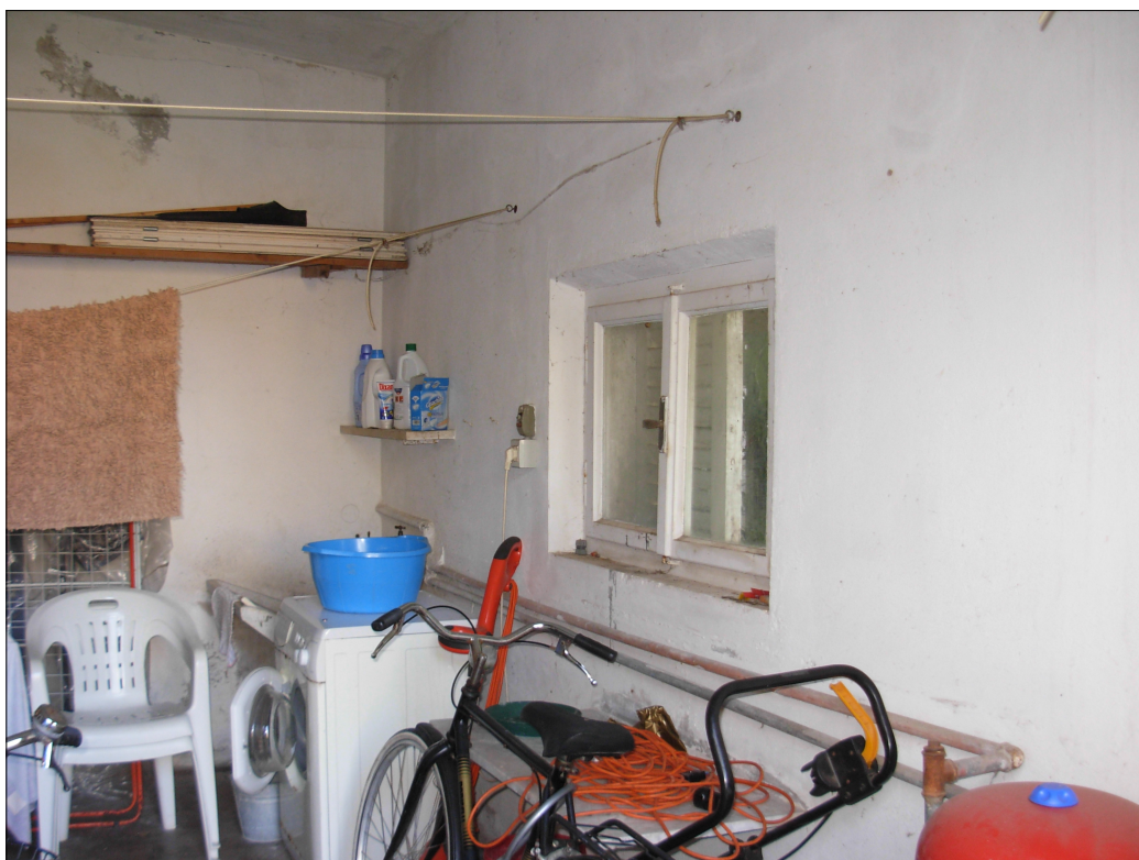
vista interna - box
