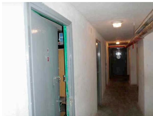
F. 28 – Ingresso alla cantina dell'u.i.u. pignorata
