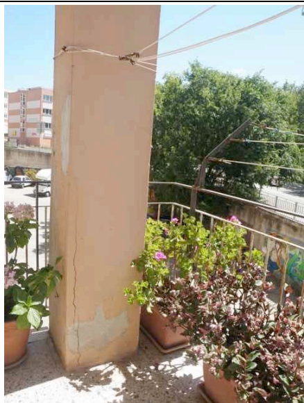
F. 17 - Balcone delle camere dell'u.i.u. pignorata
