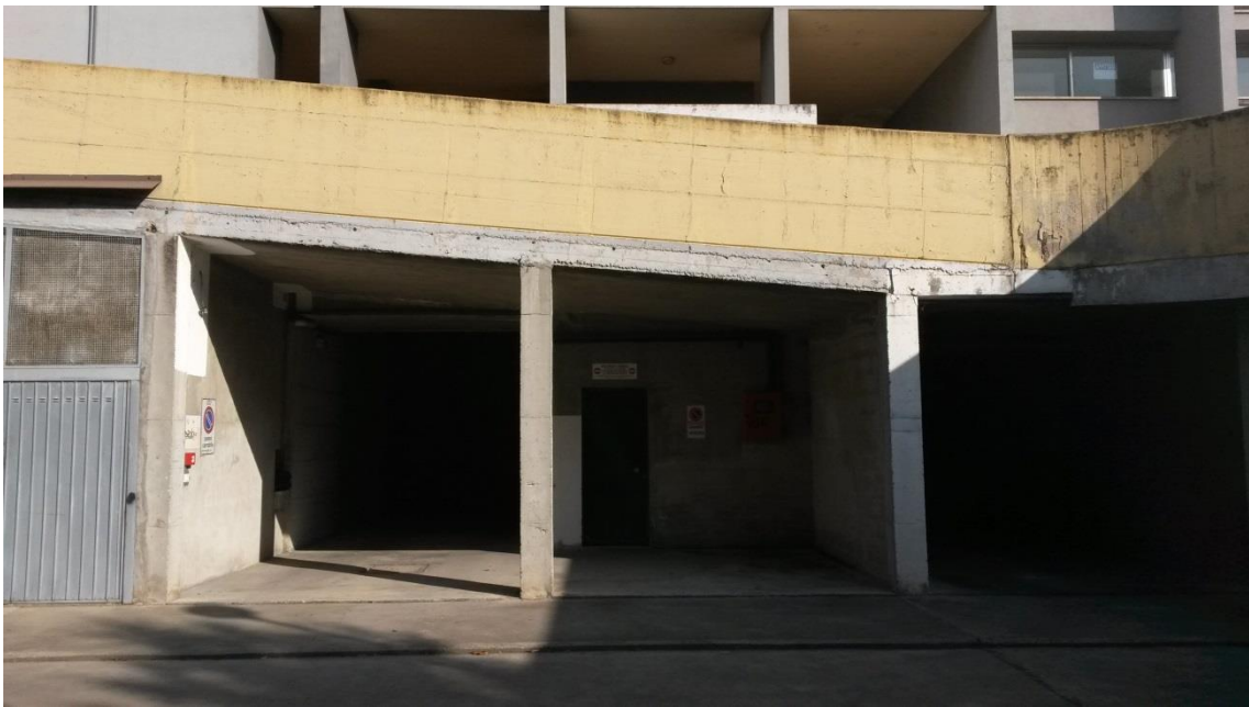
Cortile comune ingresso autorimesse PS
