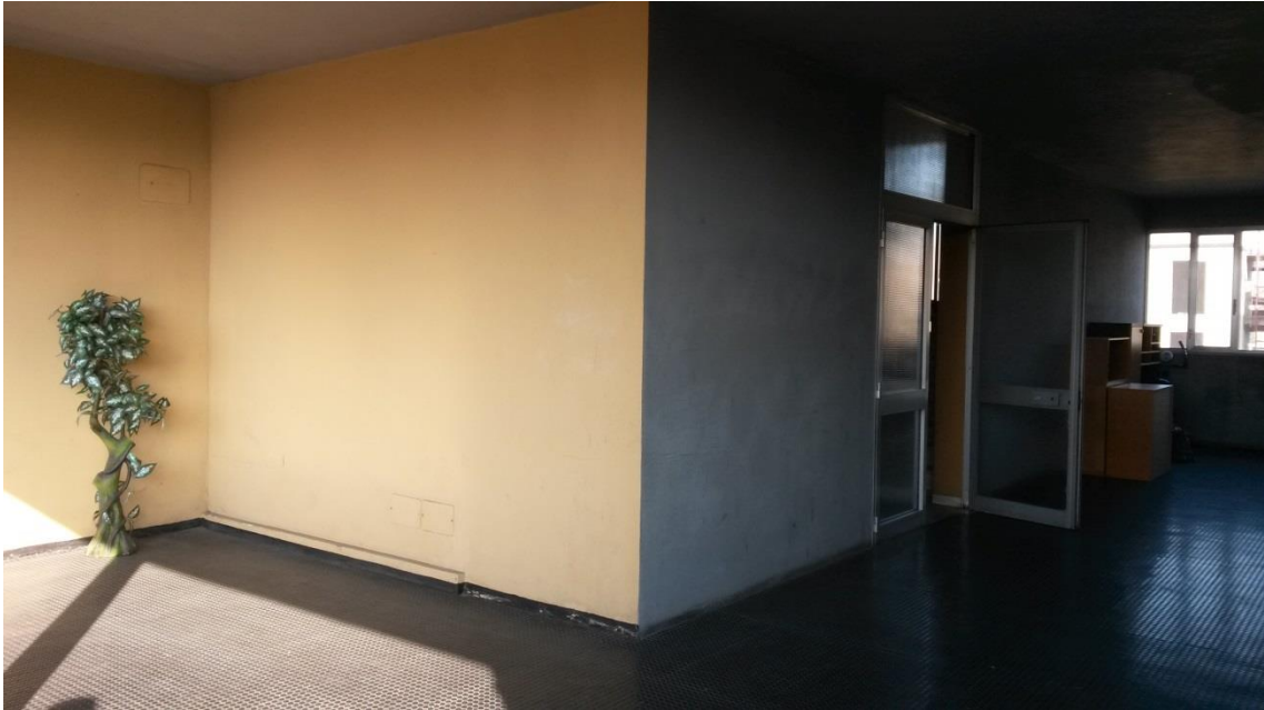
Portico condominiale di accesso agli appartamenti P2°
