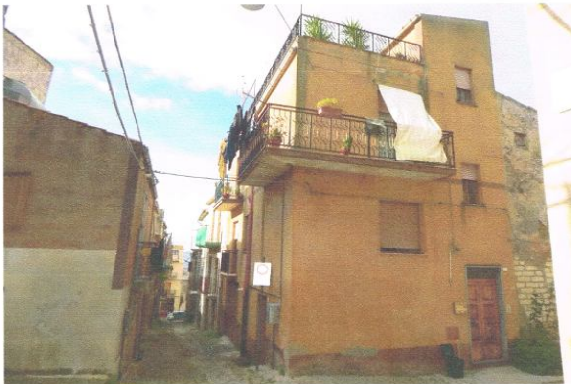
FOTO 1 – Fabbricato sito tra la via Cancellieri e la via Martina
