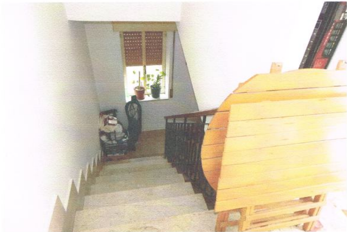
FOTO 14 – Vano scala a piano terzo
