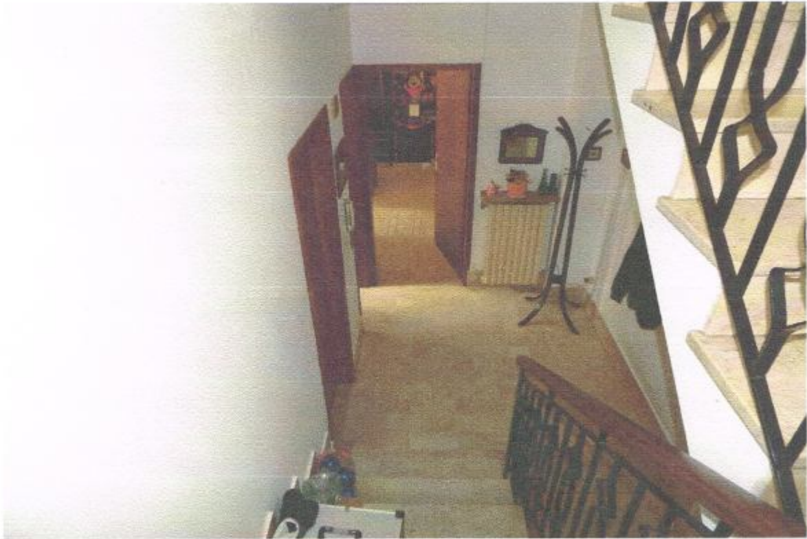
FOTO 13 – Vano scala a piano secondo
