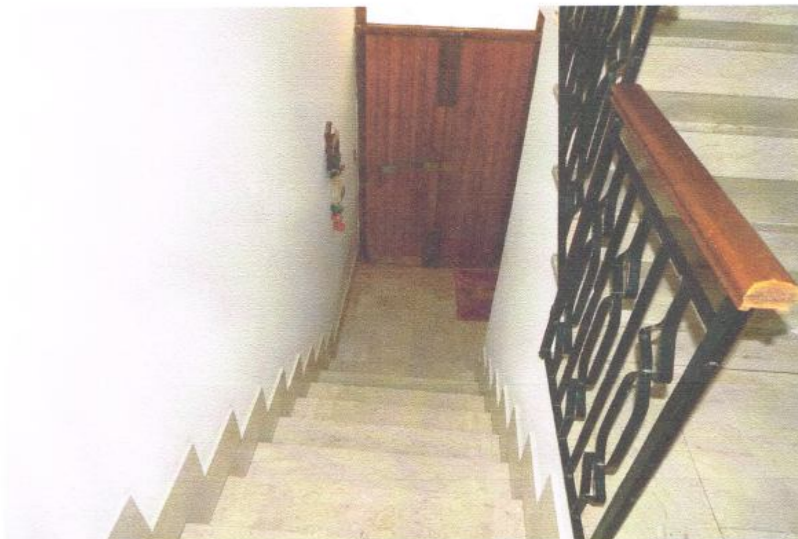
FOTO 6 – Vano scala a piano primo
