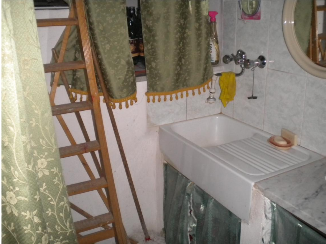
Foto n. 30 (w.c. 3 al piano primo )
