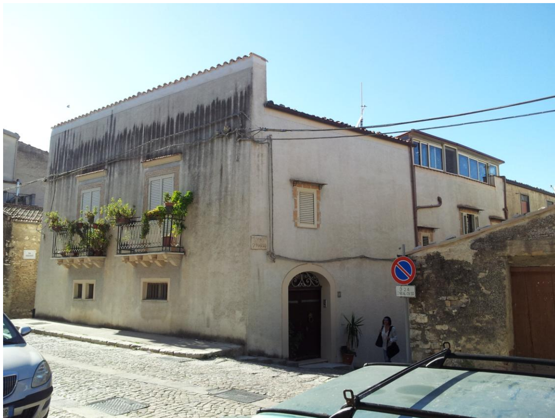
Foto n. 3 ( angolazione lato ingresso via Di Maggio 1 )
