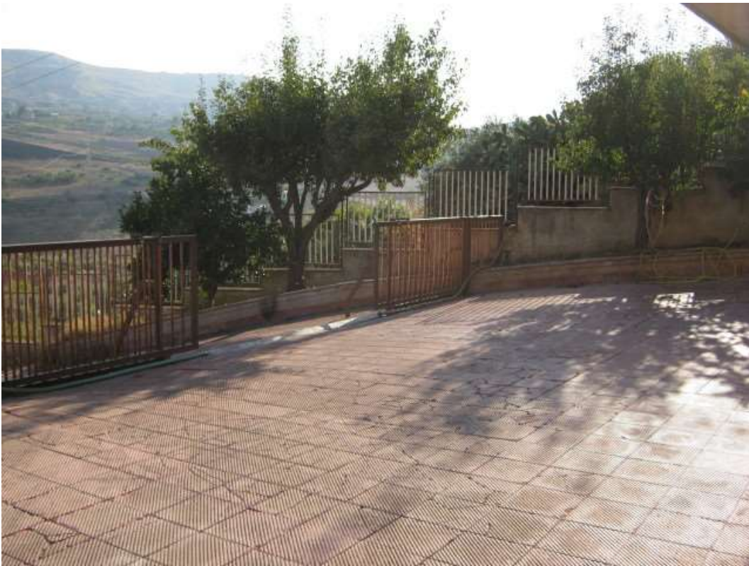
AREA ESTERNA DI PERTINENZA COMUNE
